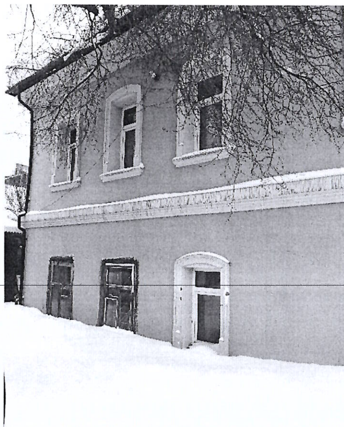
Фото 26. Юго-западный угол южного крыла здания
