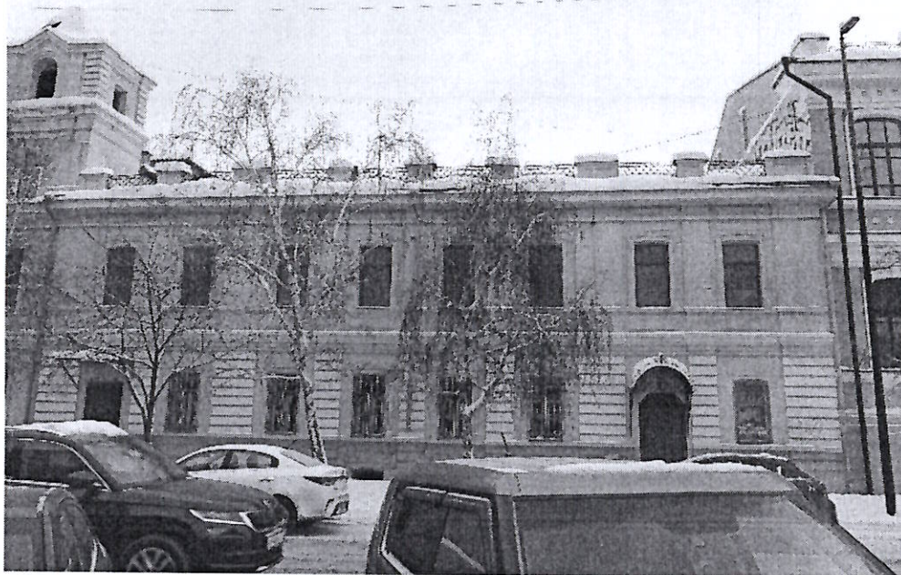
Фото 2. Фрагмент северного фасада северного крыла здания
