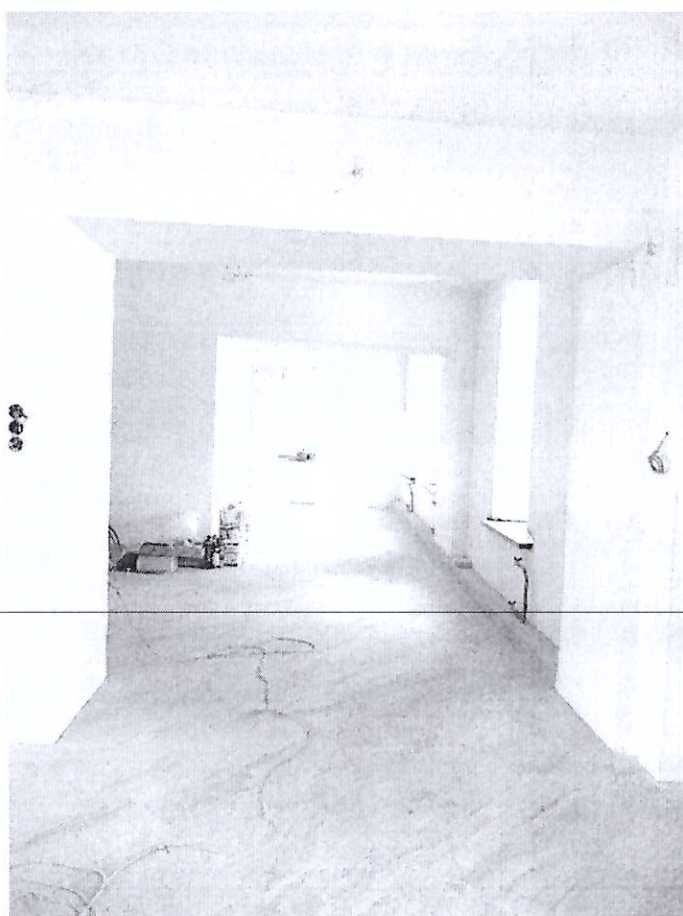
Фото 62. Помещение 2 этажа северного крыла здания
