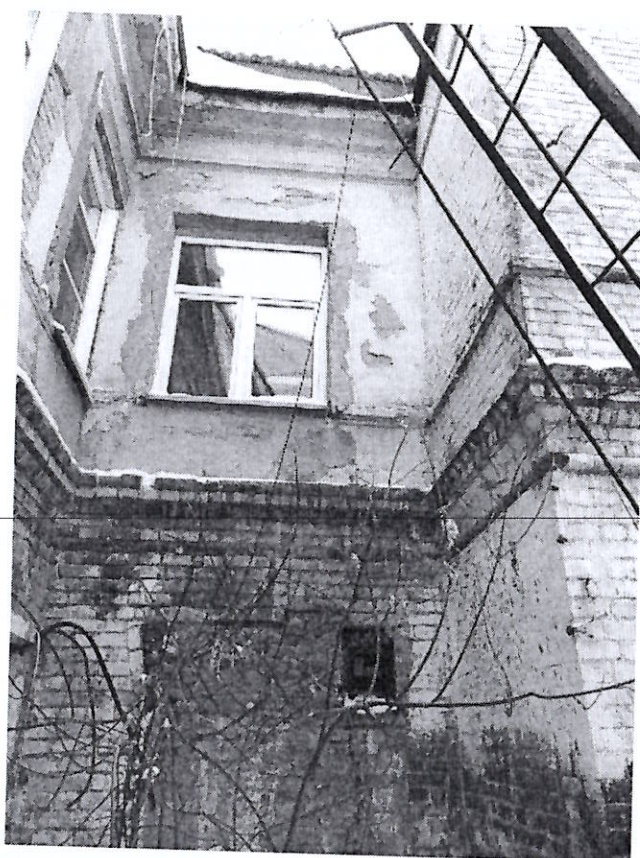
Фото 34. Соединение западного и северного крыла, северо-западный угол (заложен дверной проем)
