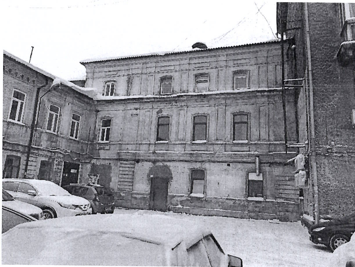
Фото 10. Вид с южной стороны на южный фасад северного крыла
