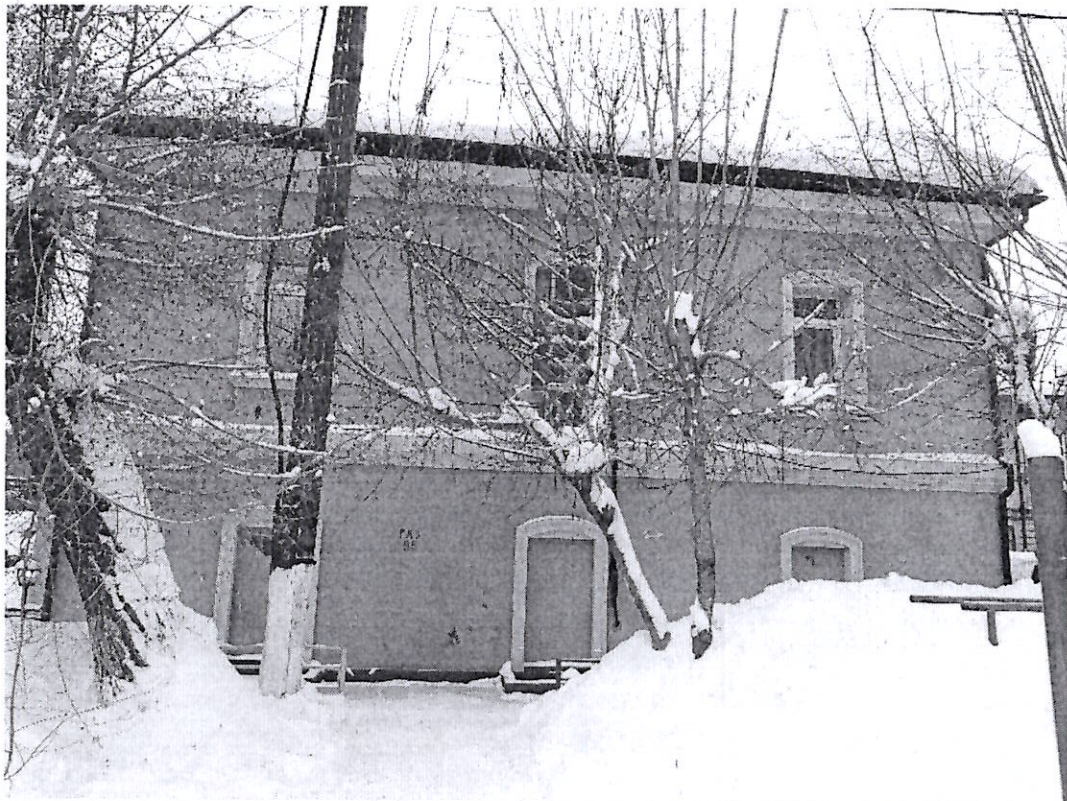
Фото 21. Вид с восточной стороны на южное крыло здания
