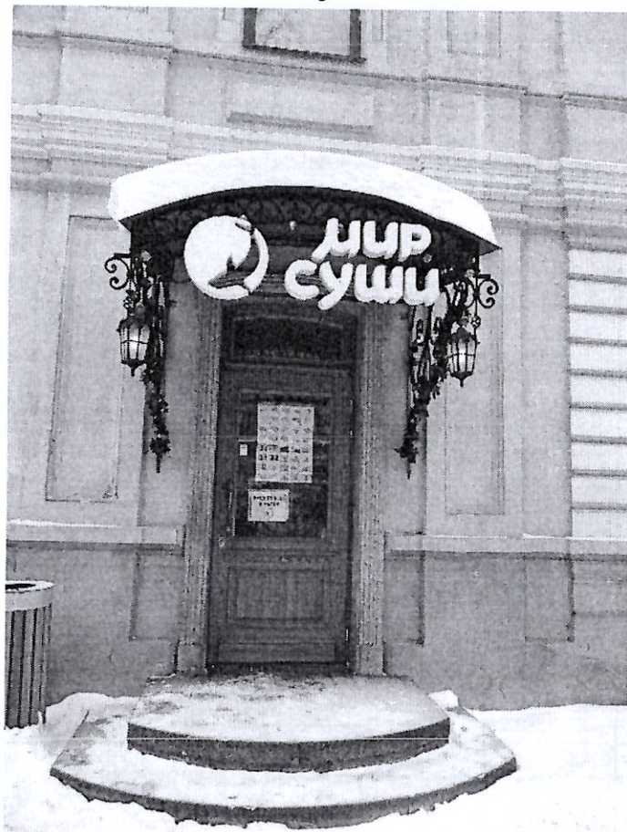
Фото 9. Вход со стороны северного фасада
