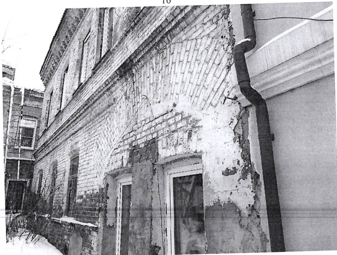
Фото 31. Фрагмент западного фасада западного крыла здания
