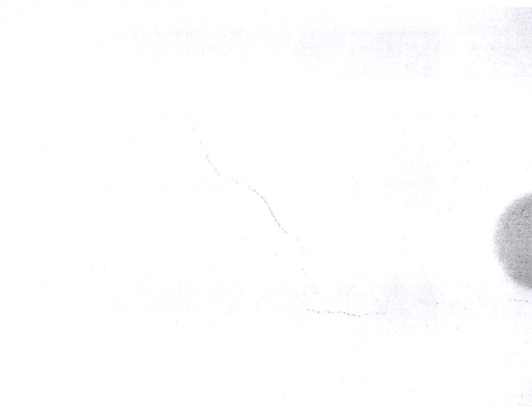
Фото 68. Трещина на стене в южном крыле здания
