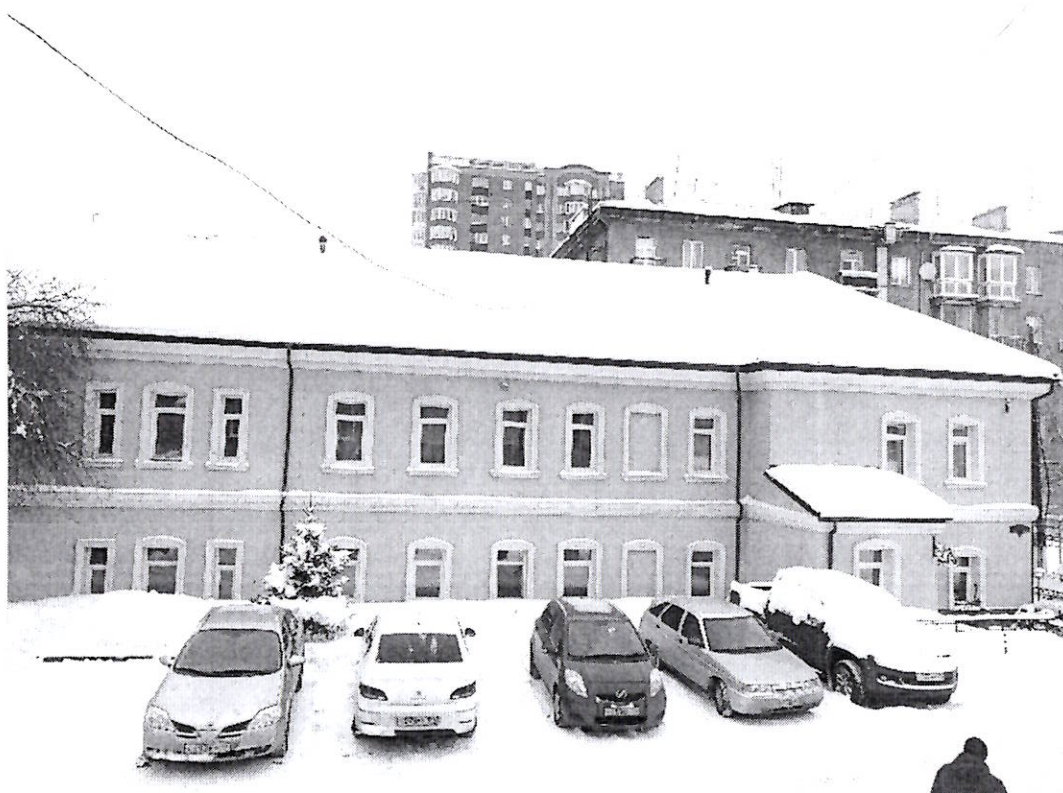
Фото 24. Вид с южной стороны на южное крыло здания
