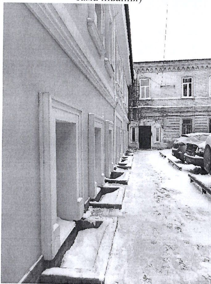
Фото 18. Вид вдоль северного фасада южного крыла здания
