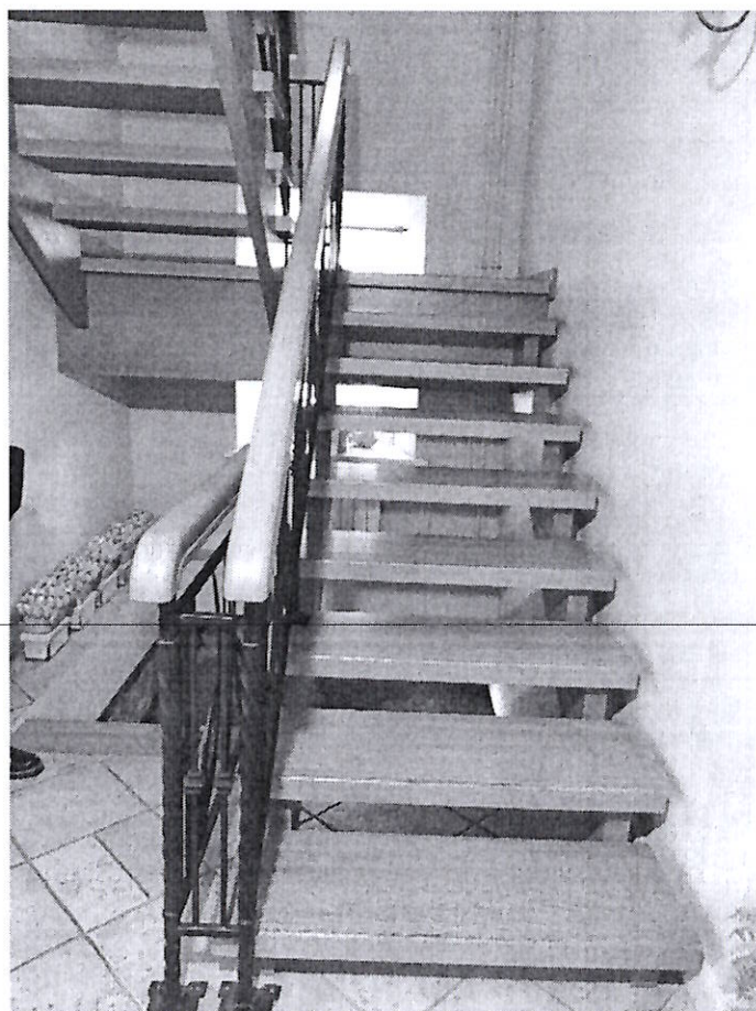
Фото 66. Лестница южного крыла здания
