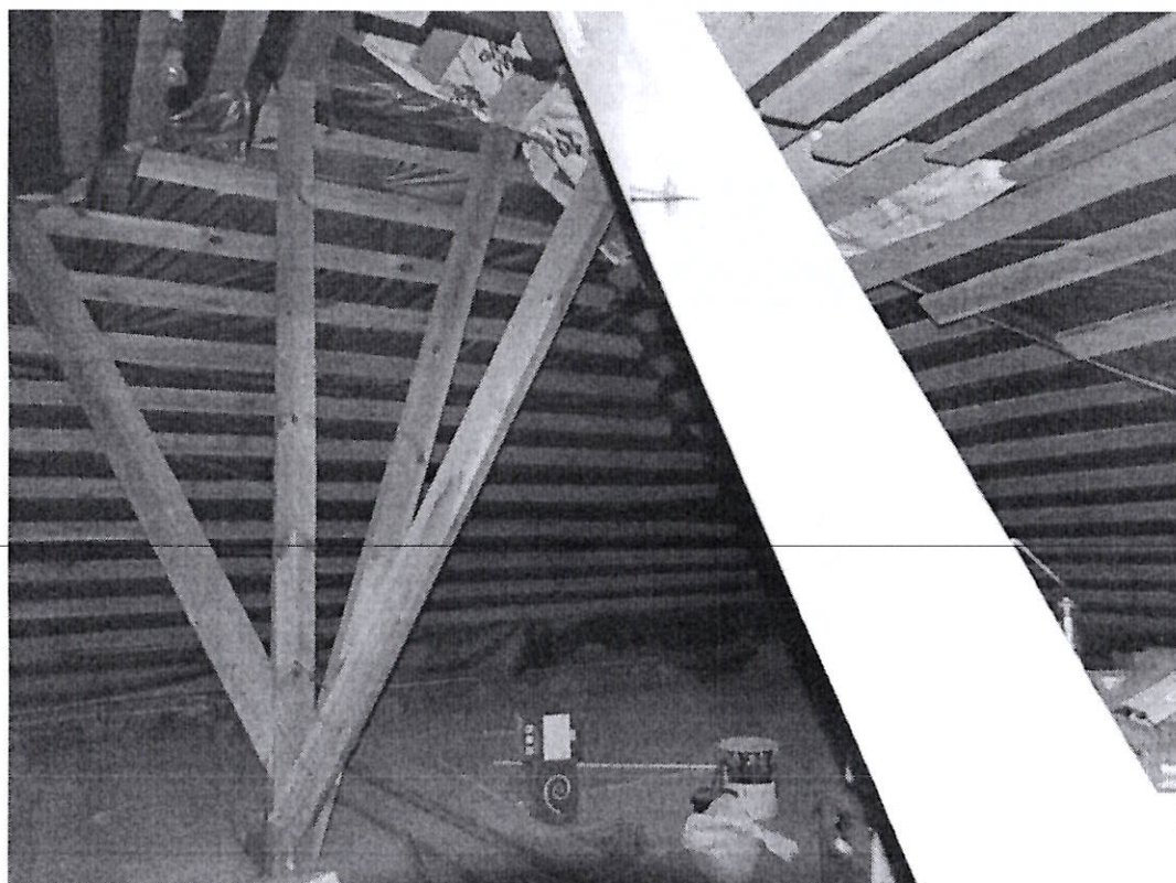
Фото 70. Чердак южного крыла здания
