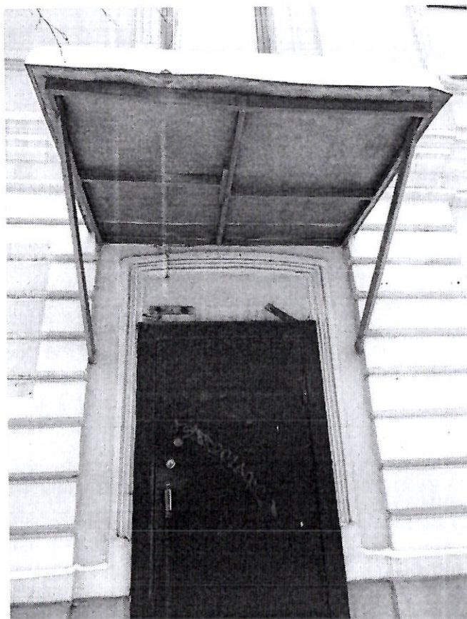
Фото 8. Вход со стороны северного фасада
