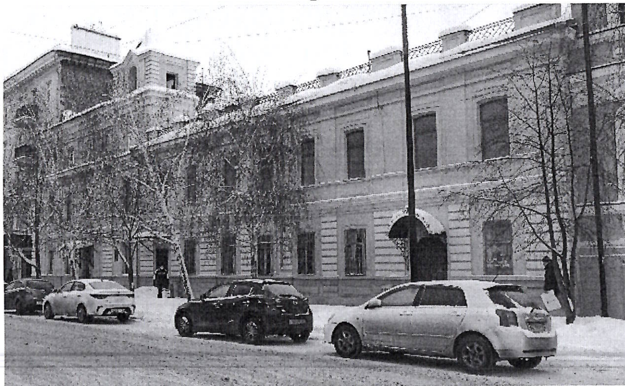
Фото 3. Вид с северо-восточной стороны на северное крыло здания
