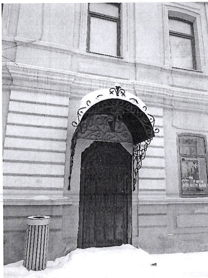
Фото 7. Вход со стороны северного фасада
