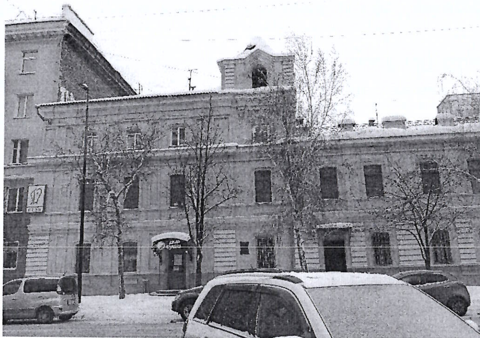
Фото 1. Фрагмент северного фасада северного крыла здания
