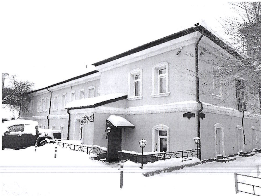
Фото 23. Вид с юго-восточной стороны на южное крыло здания
