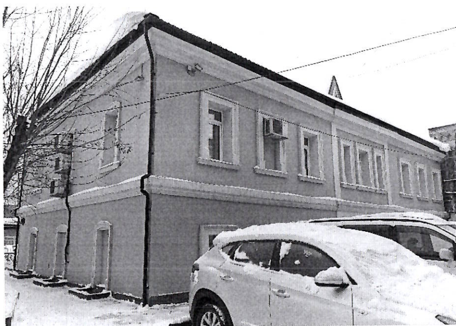
Фото 20. Вид с северо-восточной стороны на южное крыло здания
