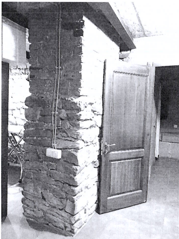
Фото 69. Столб в подвале южного крыла здания
