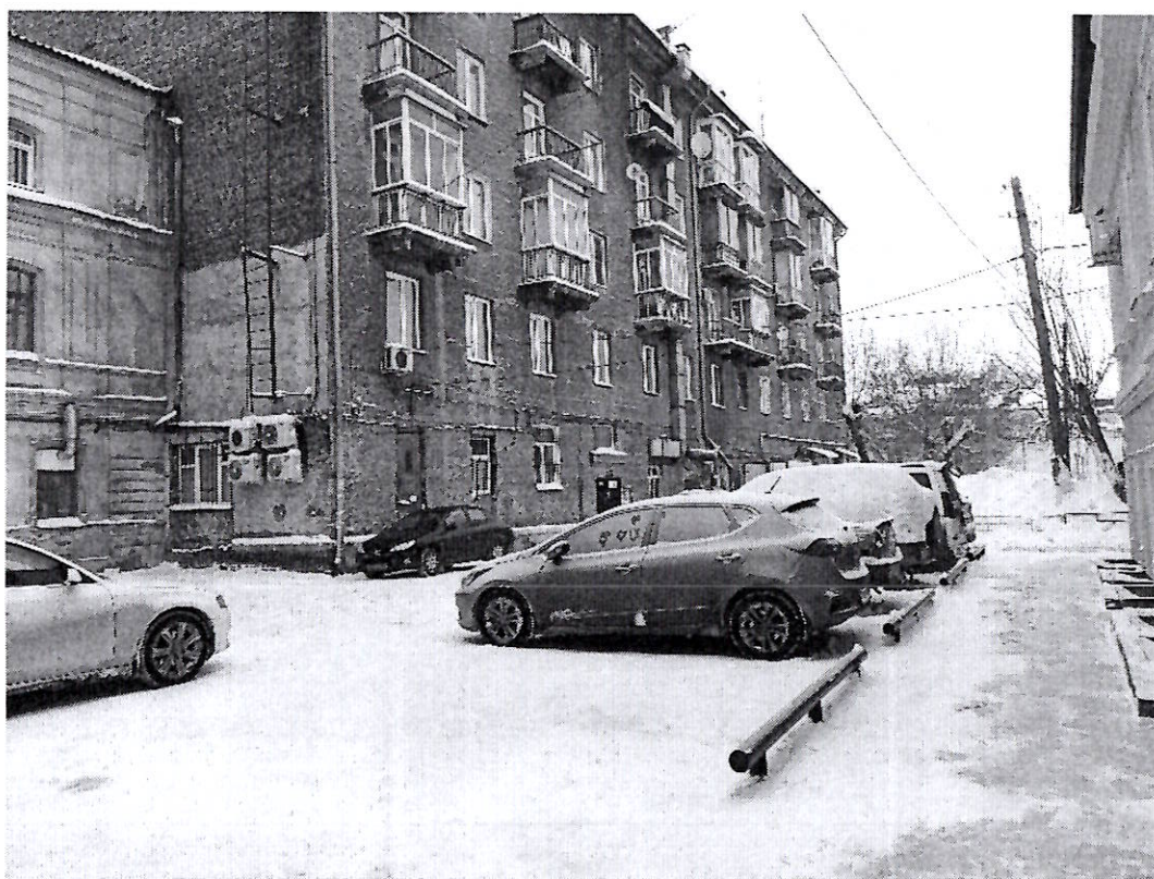
Фото 4. Вид на восточную часть территории
