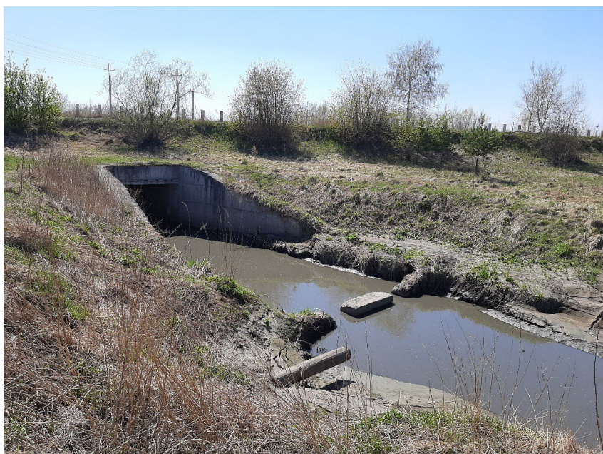
Рис. 11 – Выходная часть перепускного коллектора руч. Черёмушка. Общий вид 1
