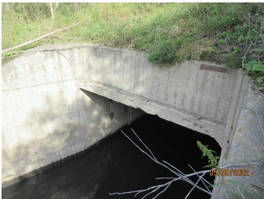
Рис. 8 – Входная часть перепускного коллектора руч. Черёмушка. Верхняя часть входа
