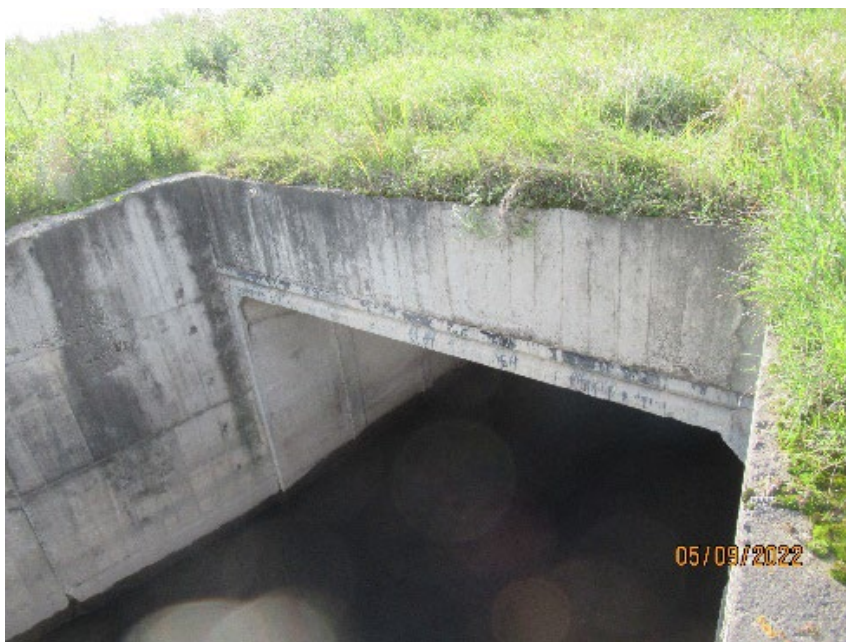
Рис. 15 – Выходная часть перепускного коллектора руч. Черёмушка. Верхняя часть выхода
