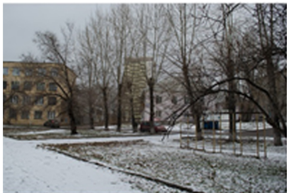
- Устаревшее, разрушенное оборудование спортивной площадки
