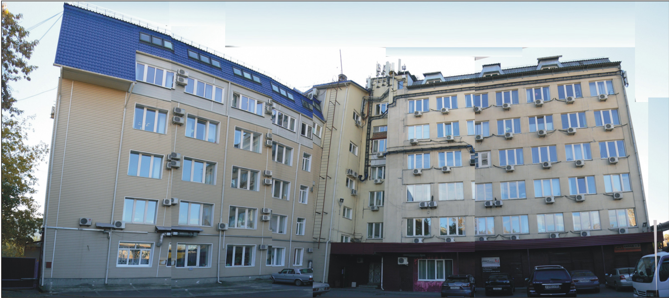
Дворовой фасад ( восточный )
