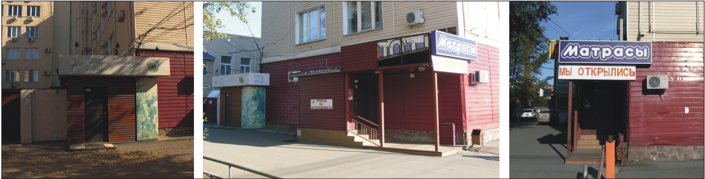
Главный фасад. Фрагменты левого крыла здания.
