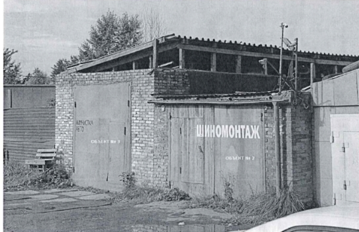
Объекты № 2 и № 3 кирпичные гаражные боксы
