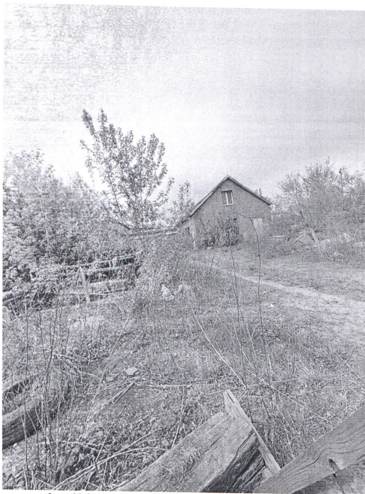
Фото № 2. Нежилое здание площадью застройки 135 кв. м
