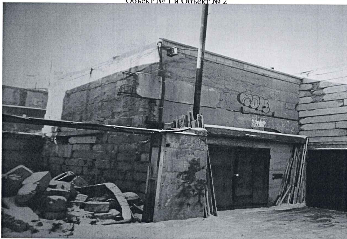
Объект № 2 первый этаж гаражный бокс, владелец не установлен
