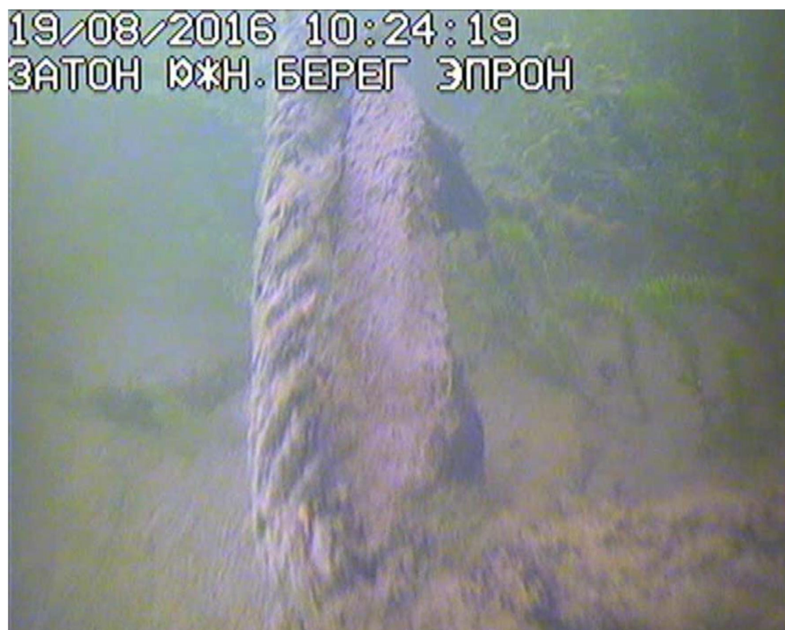
Фото 3. Металлические троса выступающие из под слоя ила.
