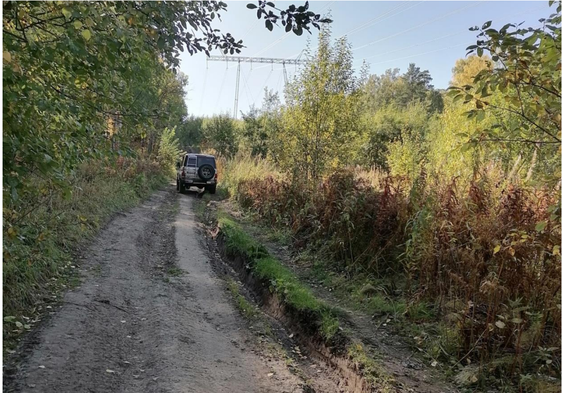
Рис. 5.6. Внедорожники на технологической дороге ВЛ 220 кВ Д-11/Д-12 "Дивногорская - Новокрасноярская" на северном склоне Гремячей гривы, г. Красноярск
