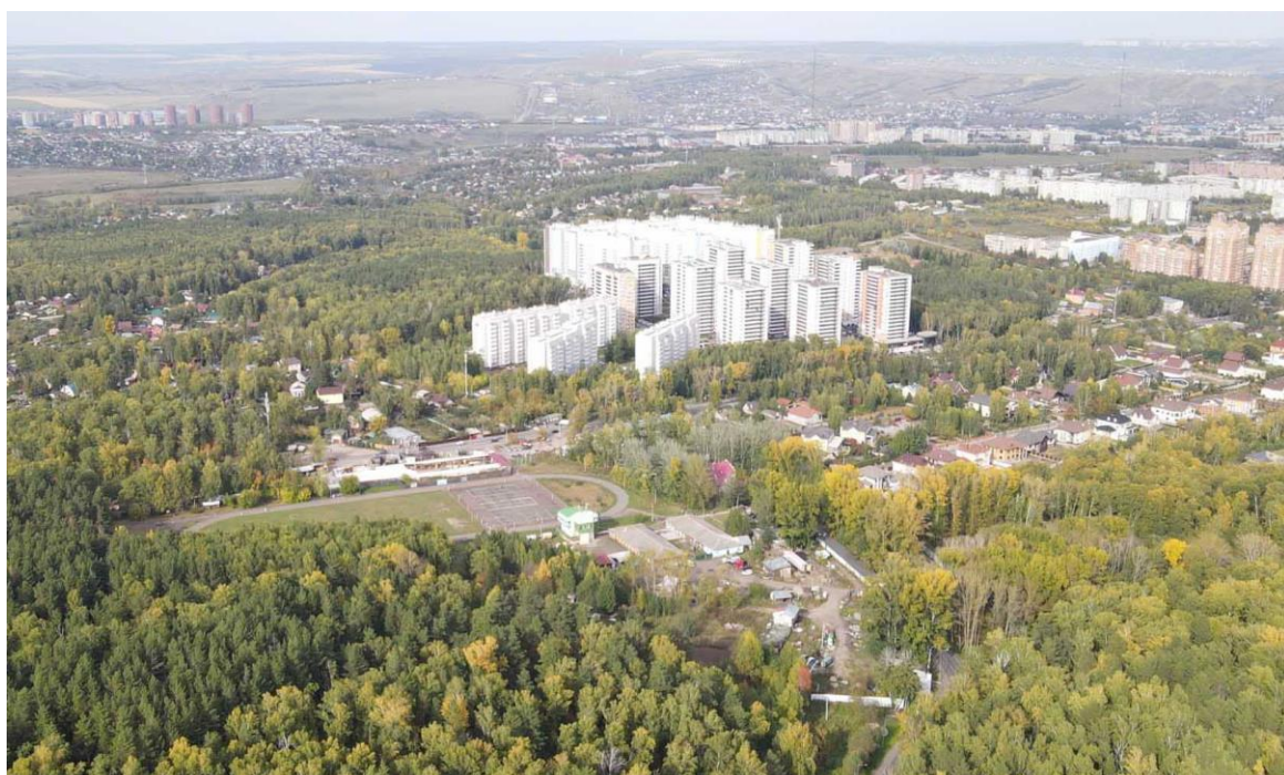
Рис. 3.15. Жилой микрорайон на ул. Елены Стасовой и стадион "Ветлужанка" у границы природного парка. Фото БПЛА
