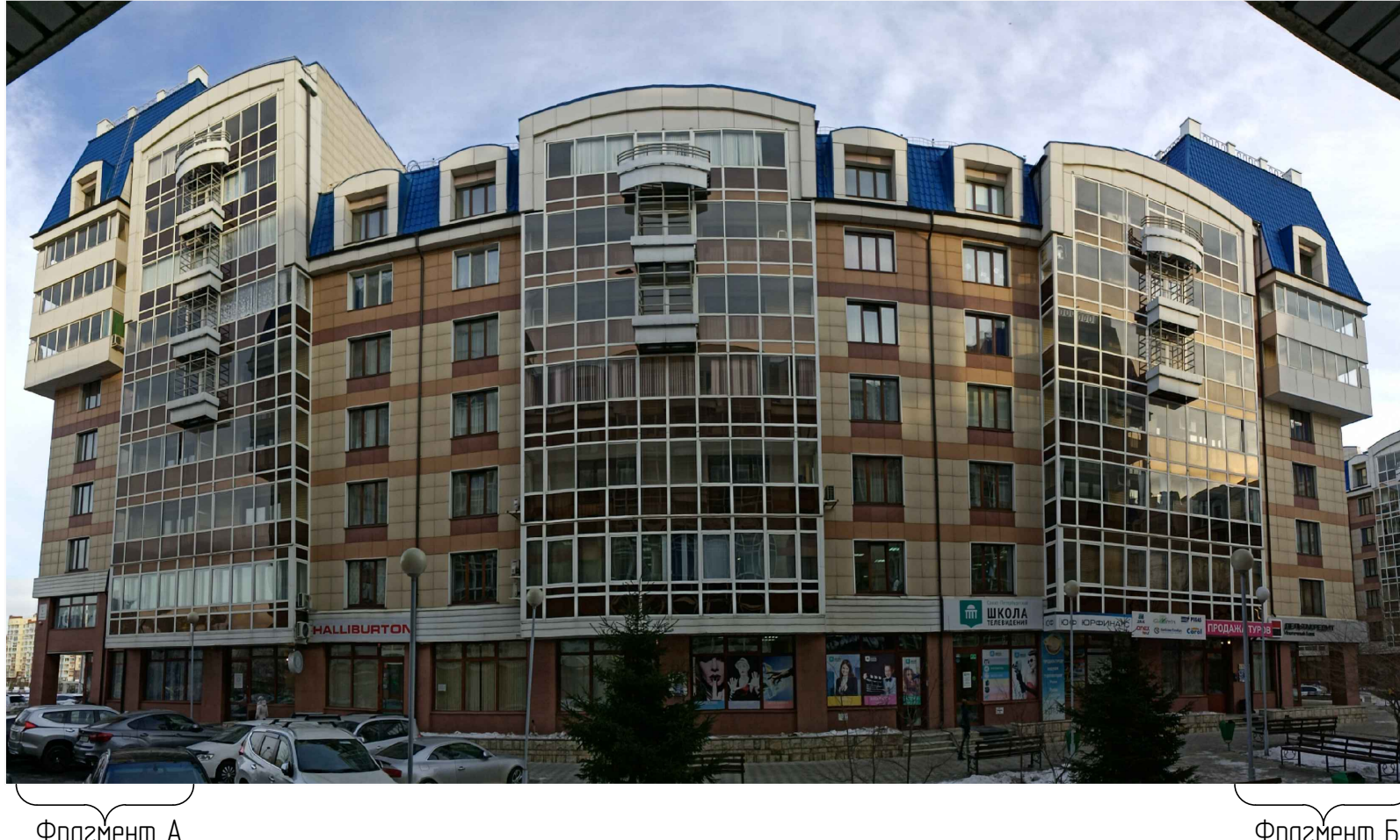
Боковой фасад (юго-западный фасад в осях 4-1)
