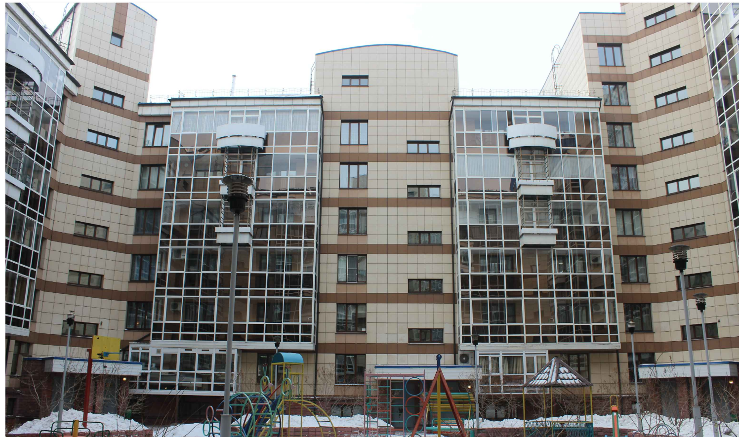
Дворовой фасад (юго-западный фасад в осях 2-3)
