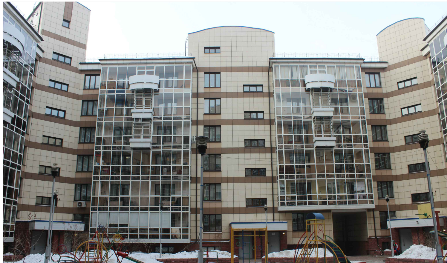
Дворовой фасад (юго-западный фасад в осях 2-3)
