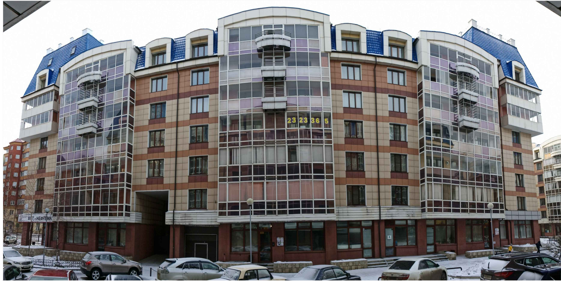
Боковой фасад (северо-восточный фасад в осях 1-4)
