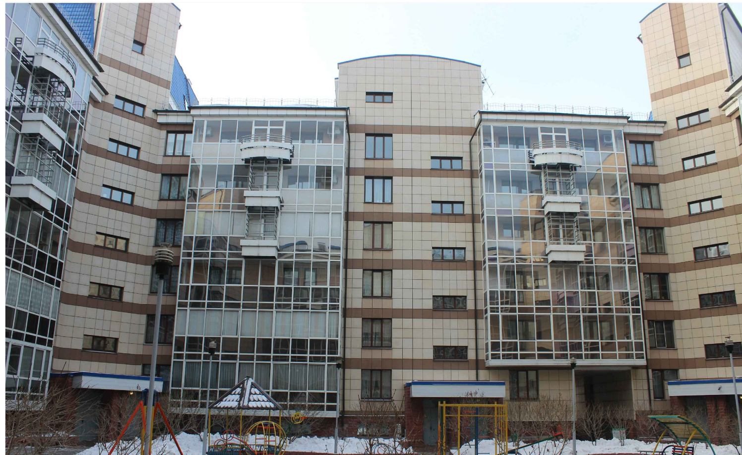
Дворовой фасад (юго-западный фасад в осях 2-3)
