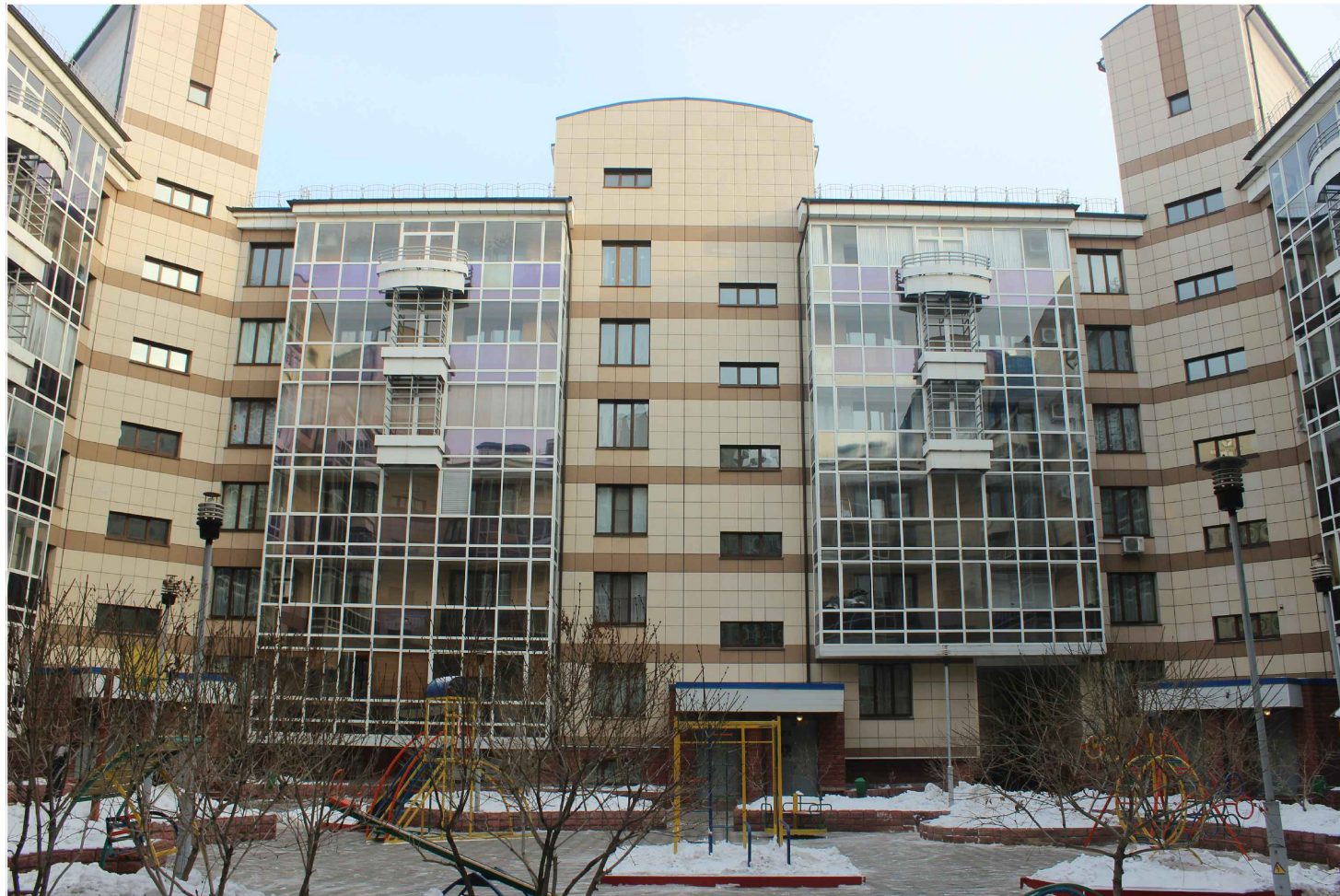
Дворовой фасад (северо-восточный фасад в осях 3-2)
