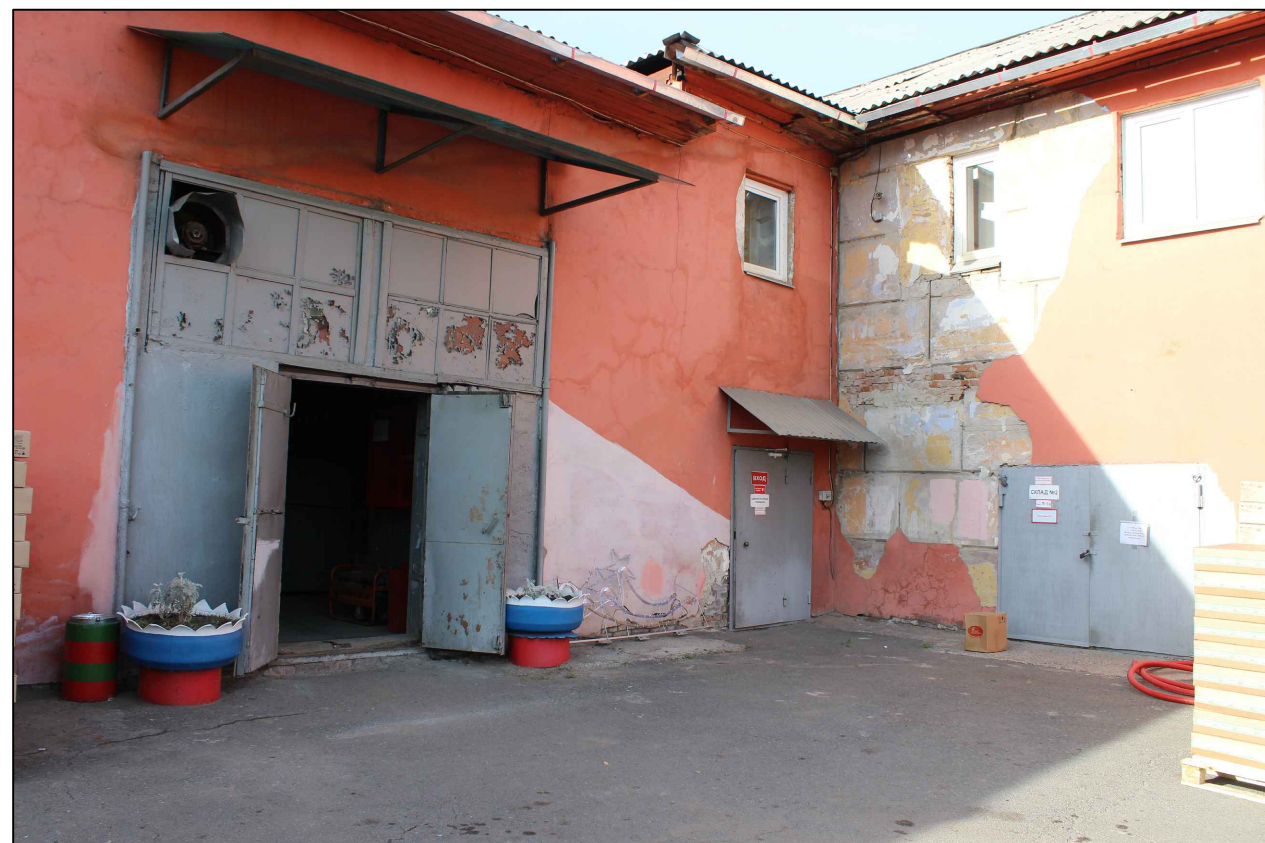
Фрагмент восточного фасада
