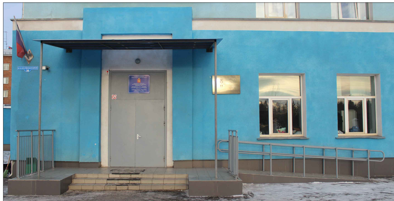
Вид Б. Фрагмент главного фасада
