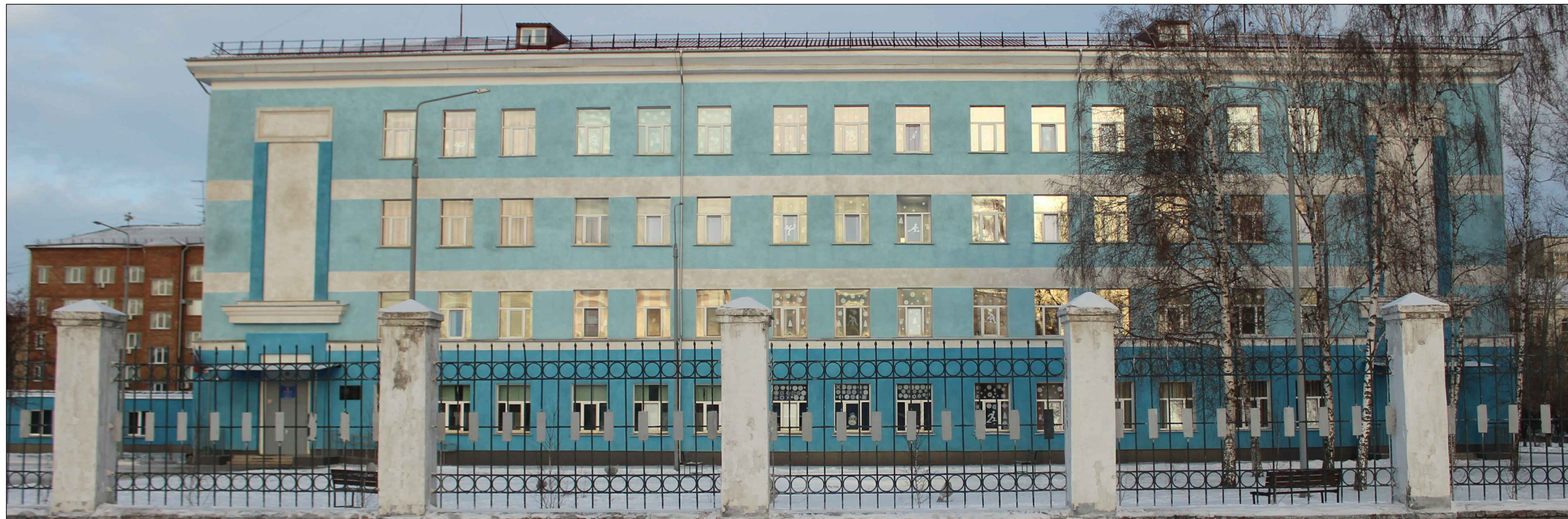
Вид А. Главный фасад в осях 3-8
