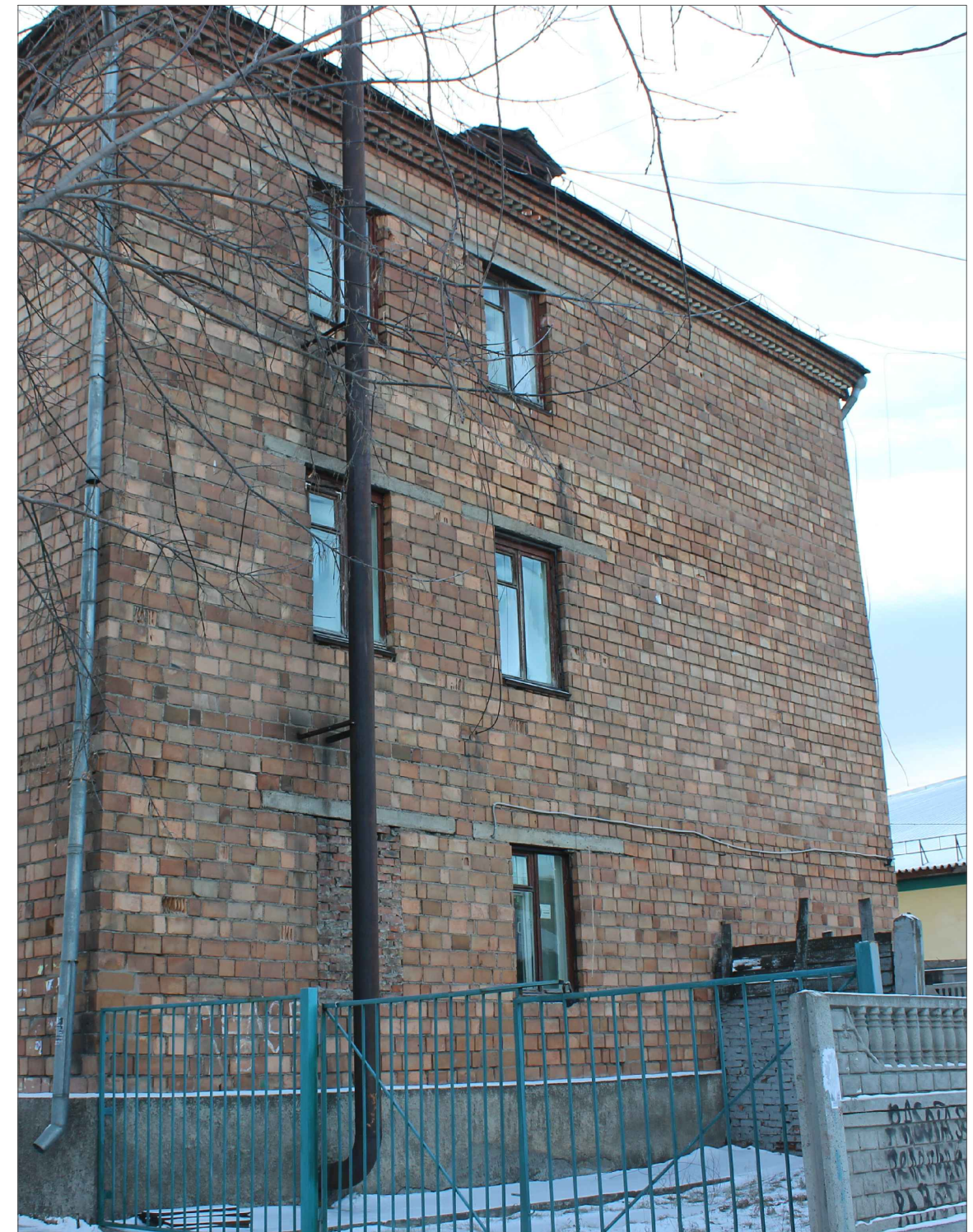
Вид К. Торцевой северный фасад в осях А-Б
