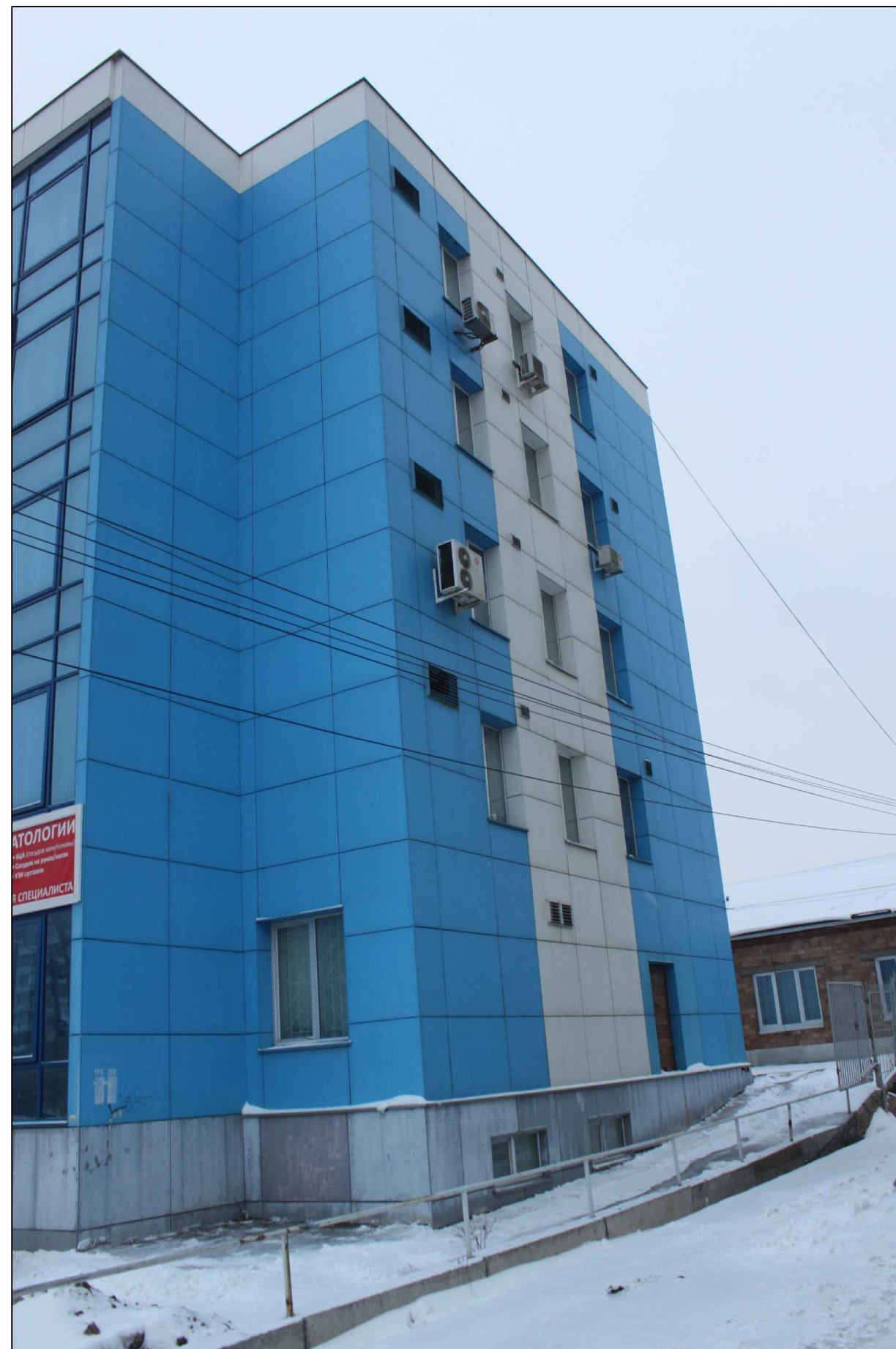
Материалы фотофиксации существующего состояния фасадов. Боковой фасад в осях А-В
