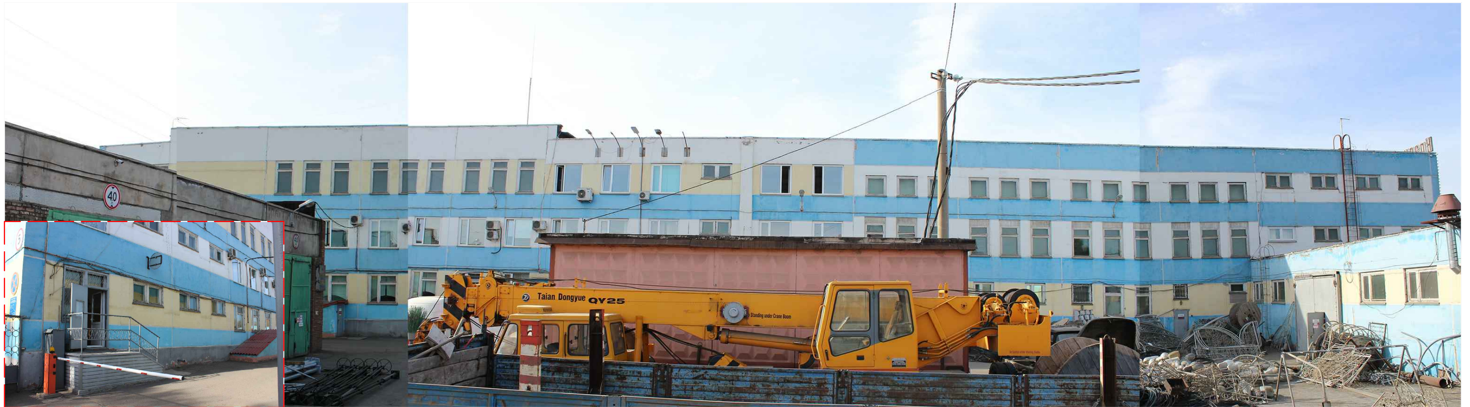
Дворовой фасад (восточный фасад в осях В-Б)
