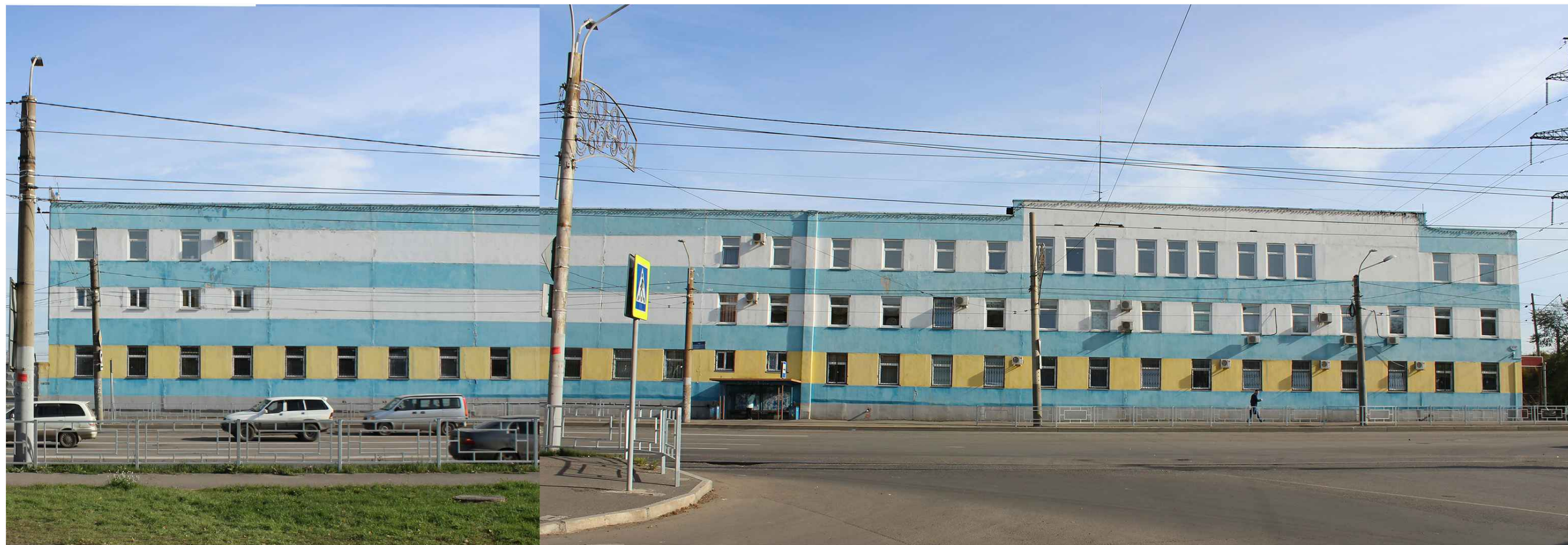
Главный фасад (западный фасад в осях А-В)
