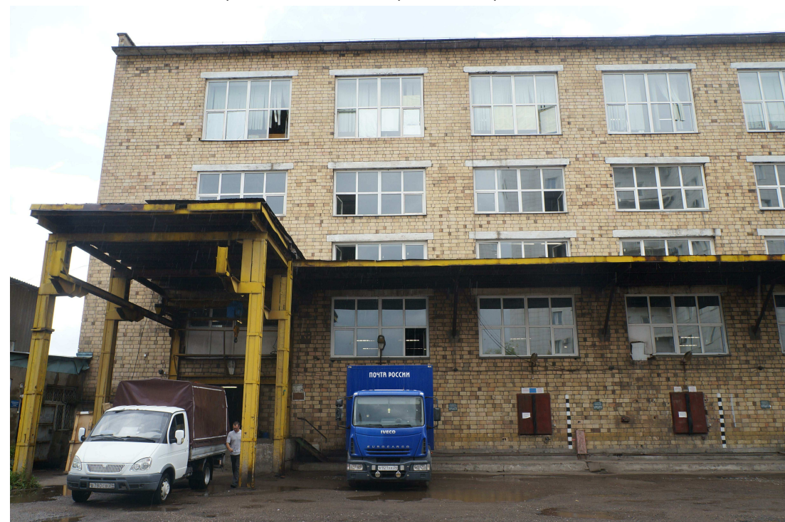
Фрагмент 1 дворового фасада
