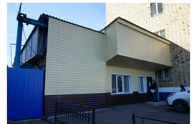
Фрагмент 3 главного фасада
