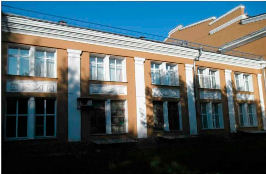
Фрагмент фасада в осях Е-А
