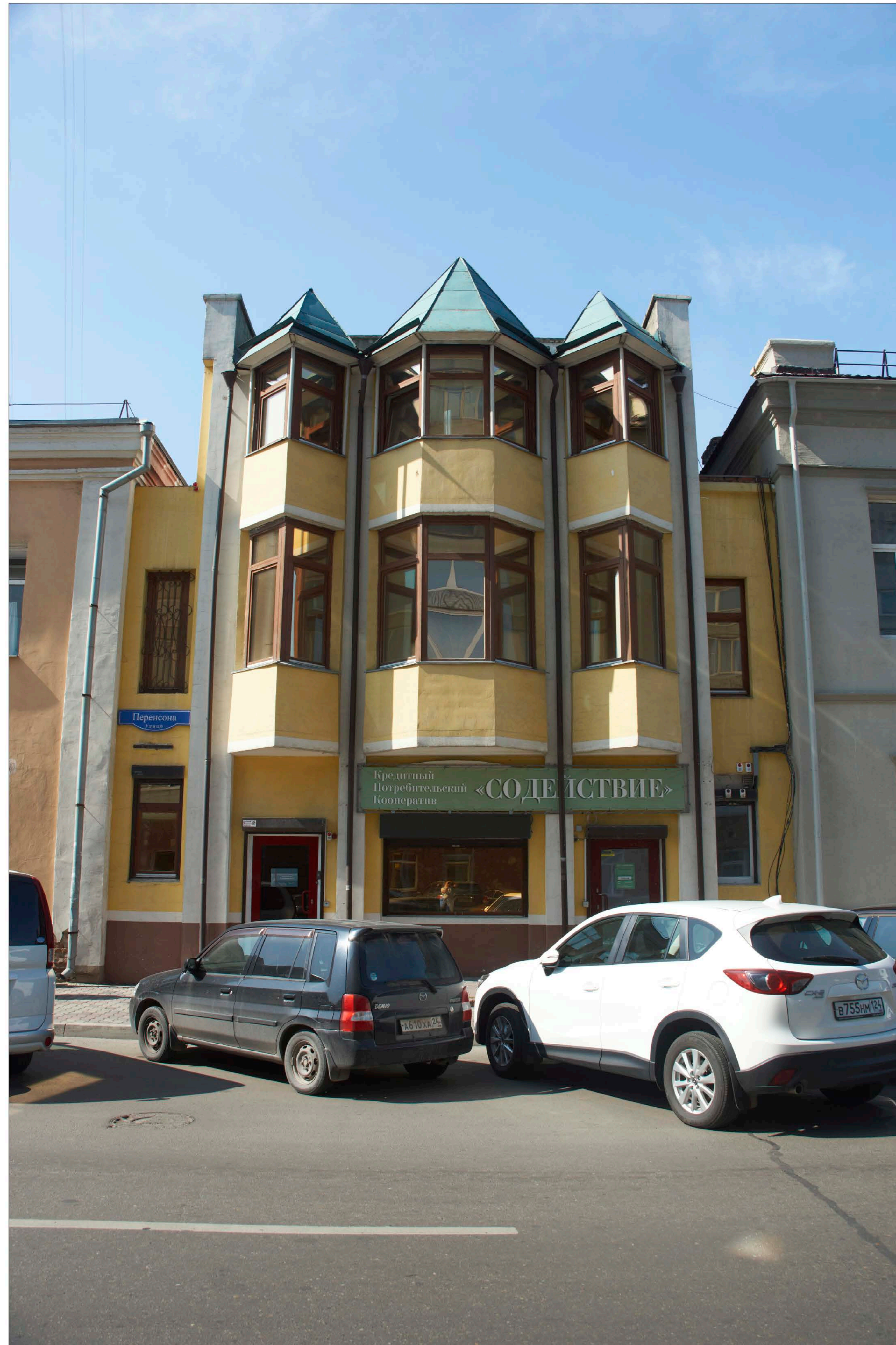
ФАСАД ПО УЛ.ПЕРЕНСОНА, Д.21А
