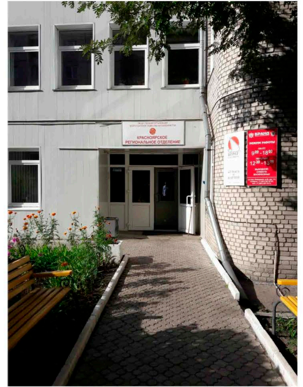
Фрагмент главного входа
