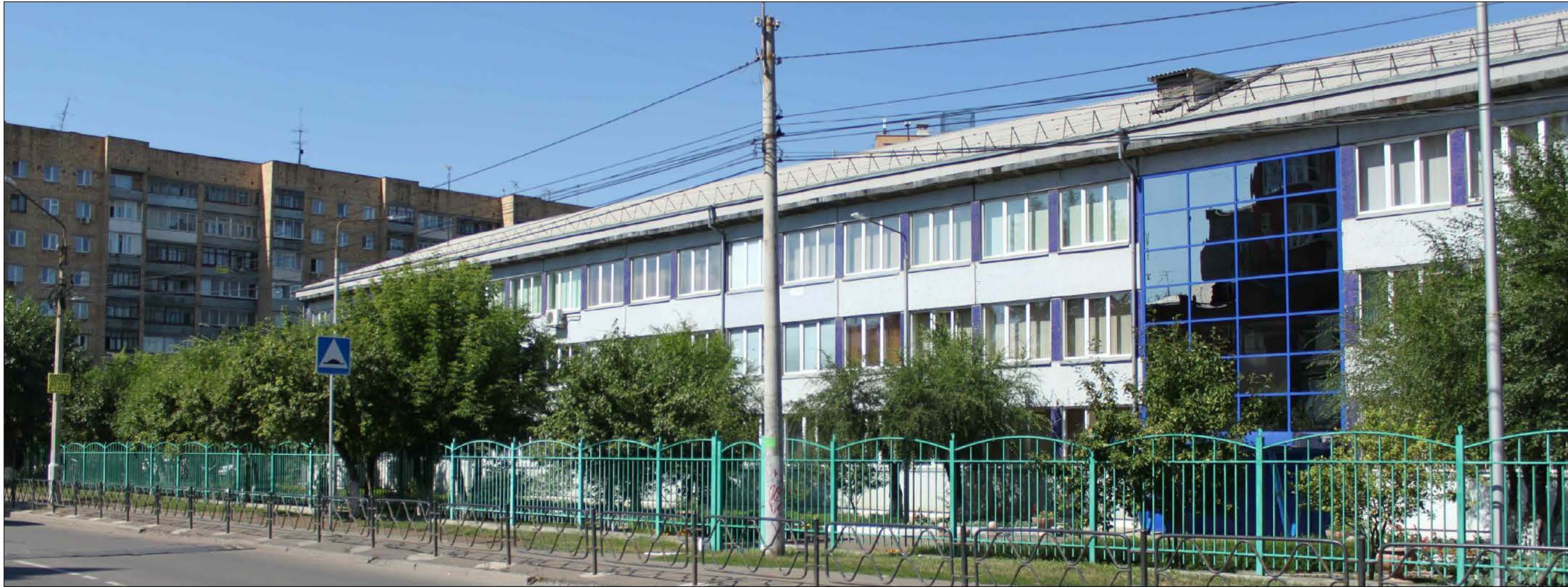
Материалы фотофиксации существующего состояния фасадов. Боковой фасад в осях Г-А
