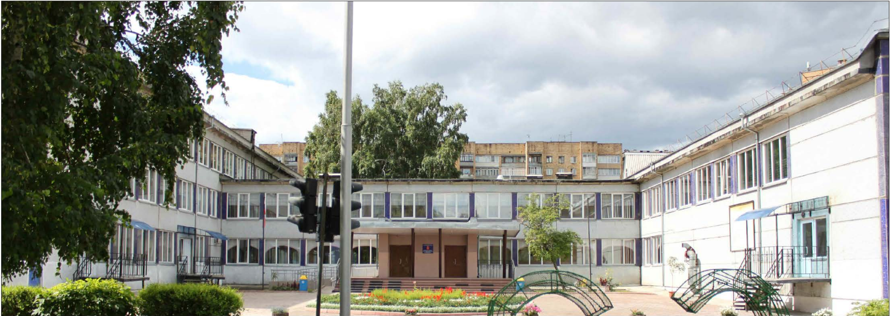
Материалы фотофиксации существующего состояния фасадов. Главный фасад в осях 1-4
