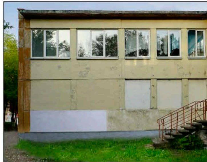
Фасад в осях "Г-В/3"
