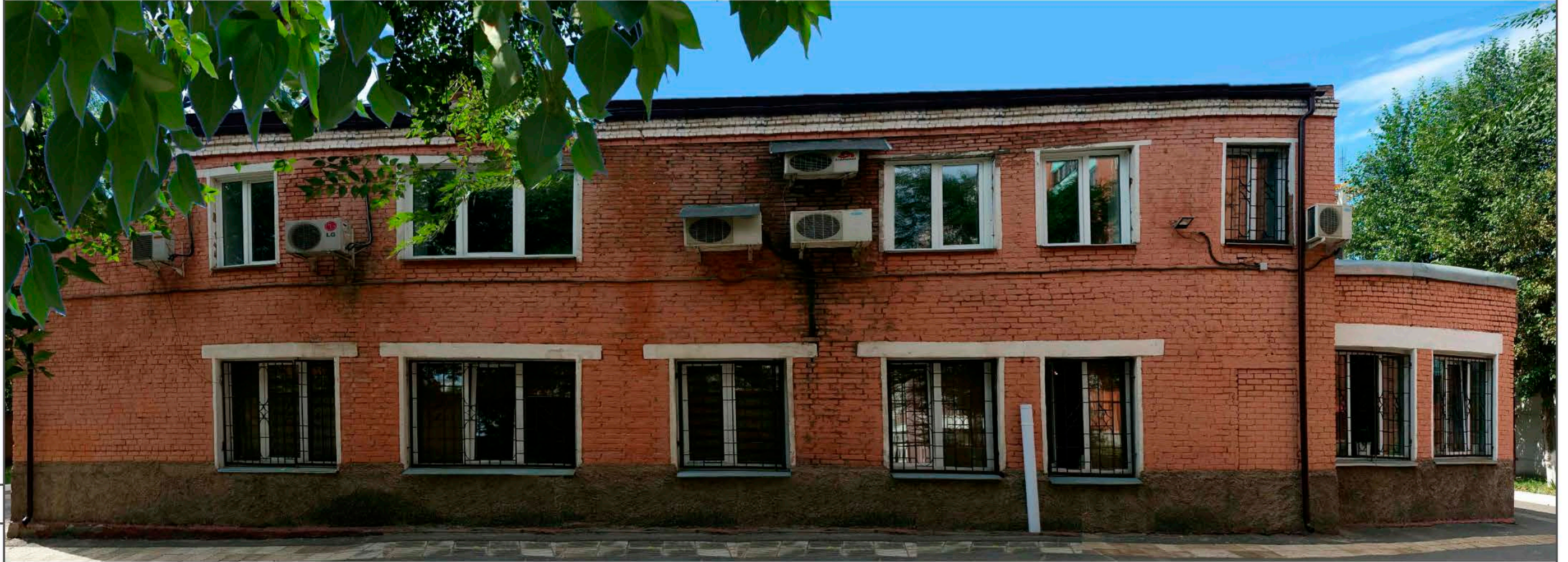
Фасад в осях А-Г Вид 4
