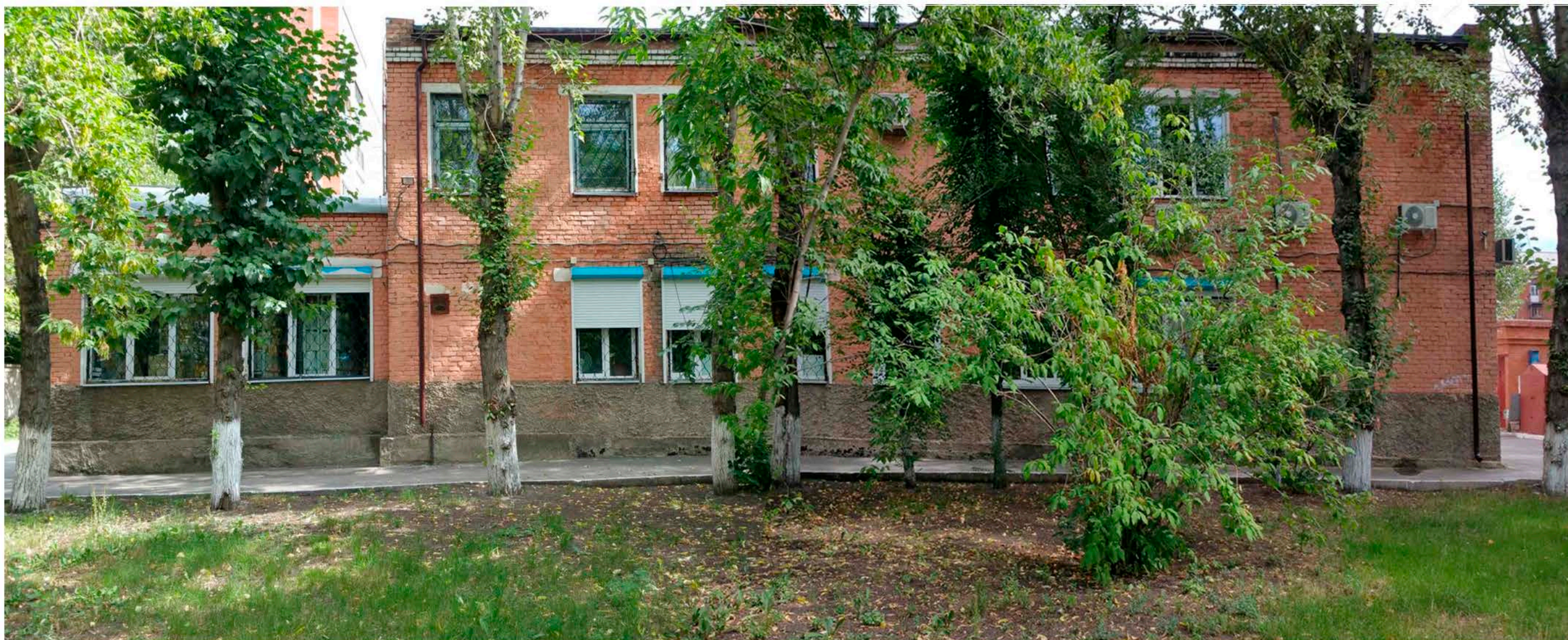
Фасад в осях Г-А Вид 5
