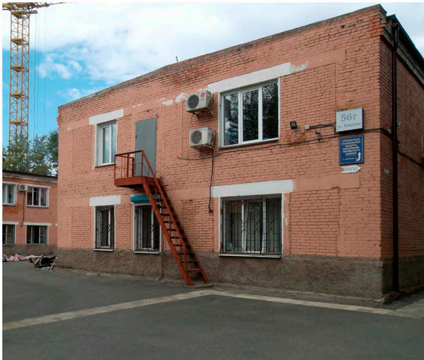
Фасад в осях 6-10. Вид 9.
