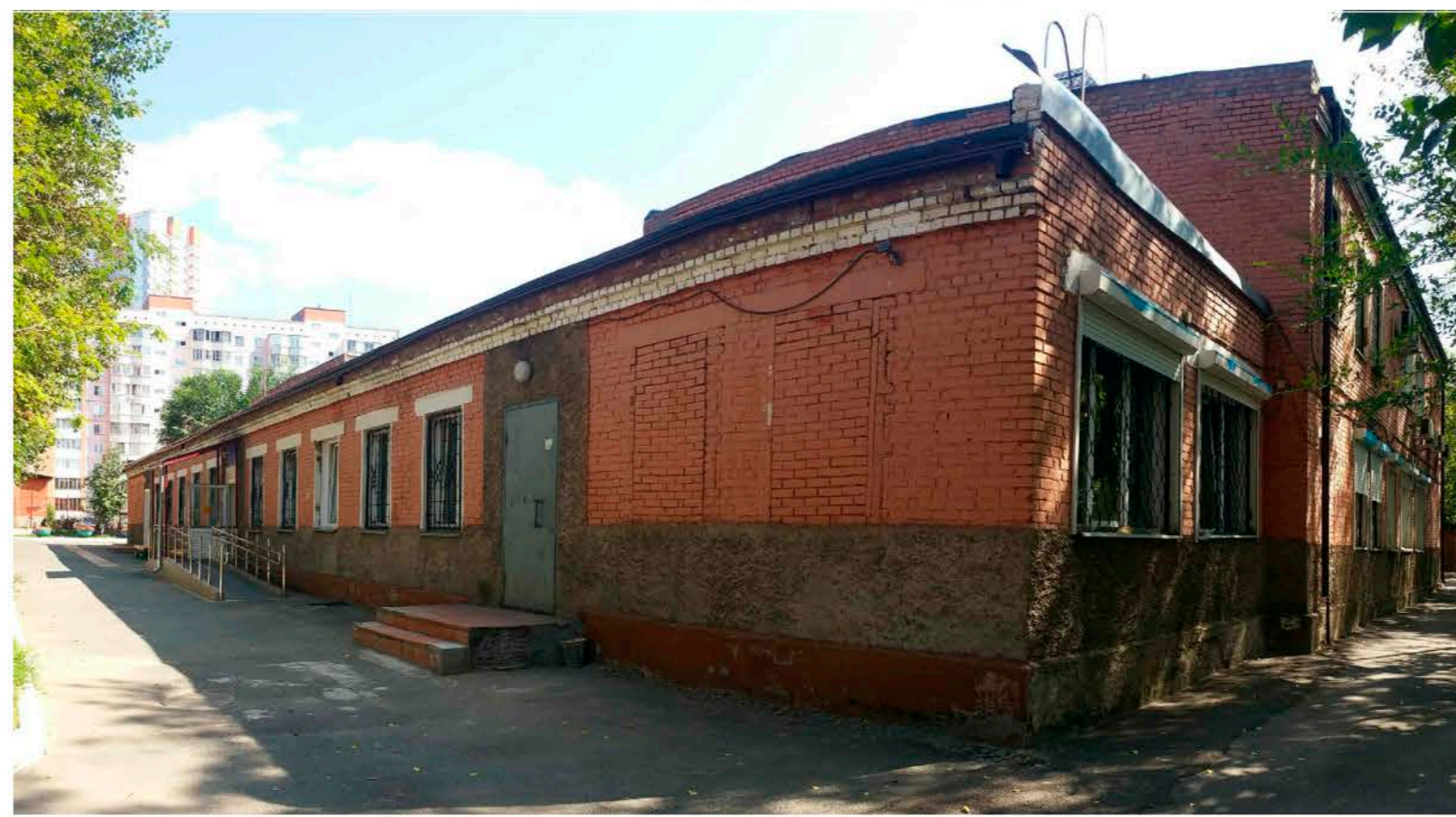
Фасад в осях 10-1 Вид 3
