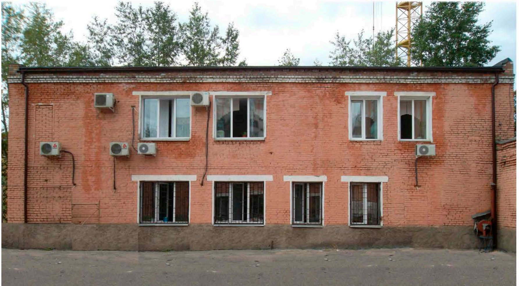
Фасад в осях А-В. Вид 7.
