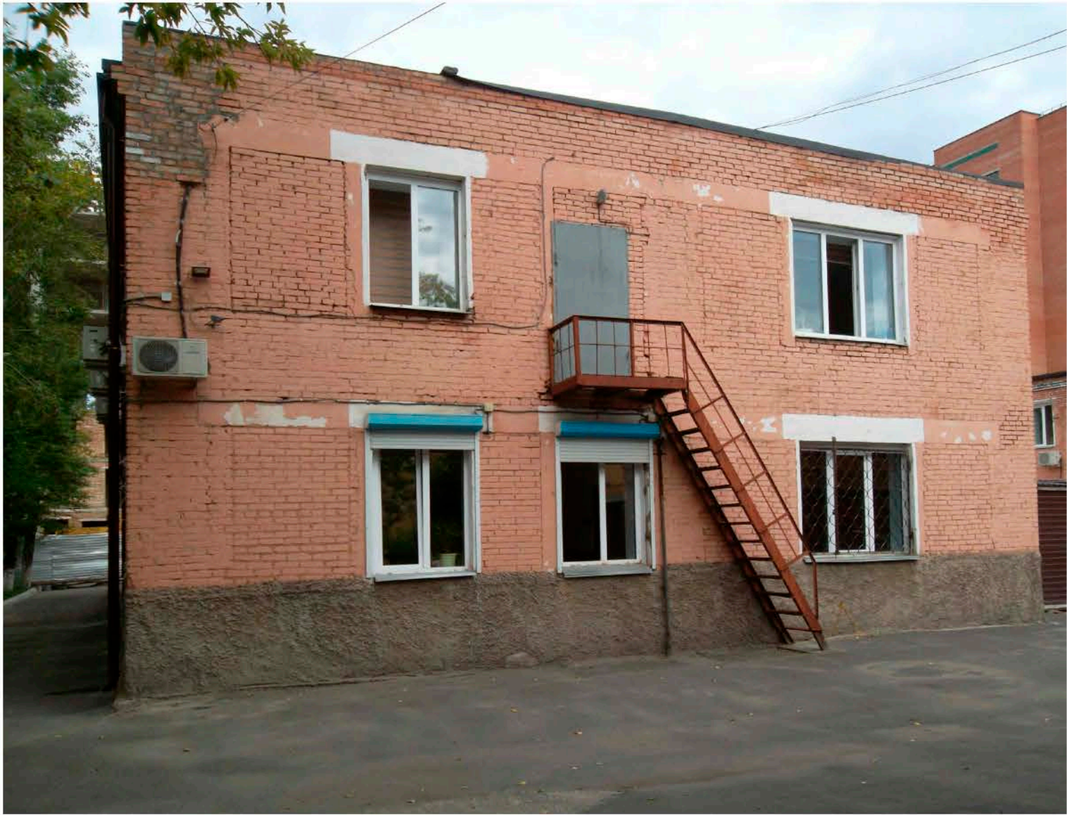
Фасад в осях 1-5. Вид 6.
