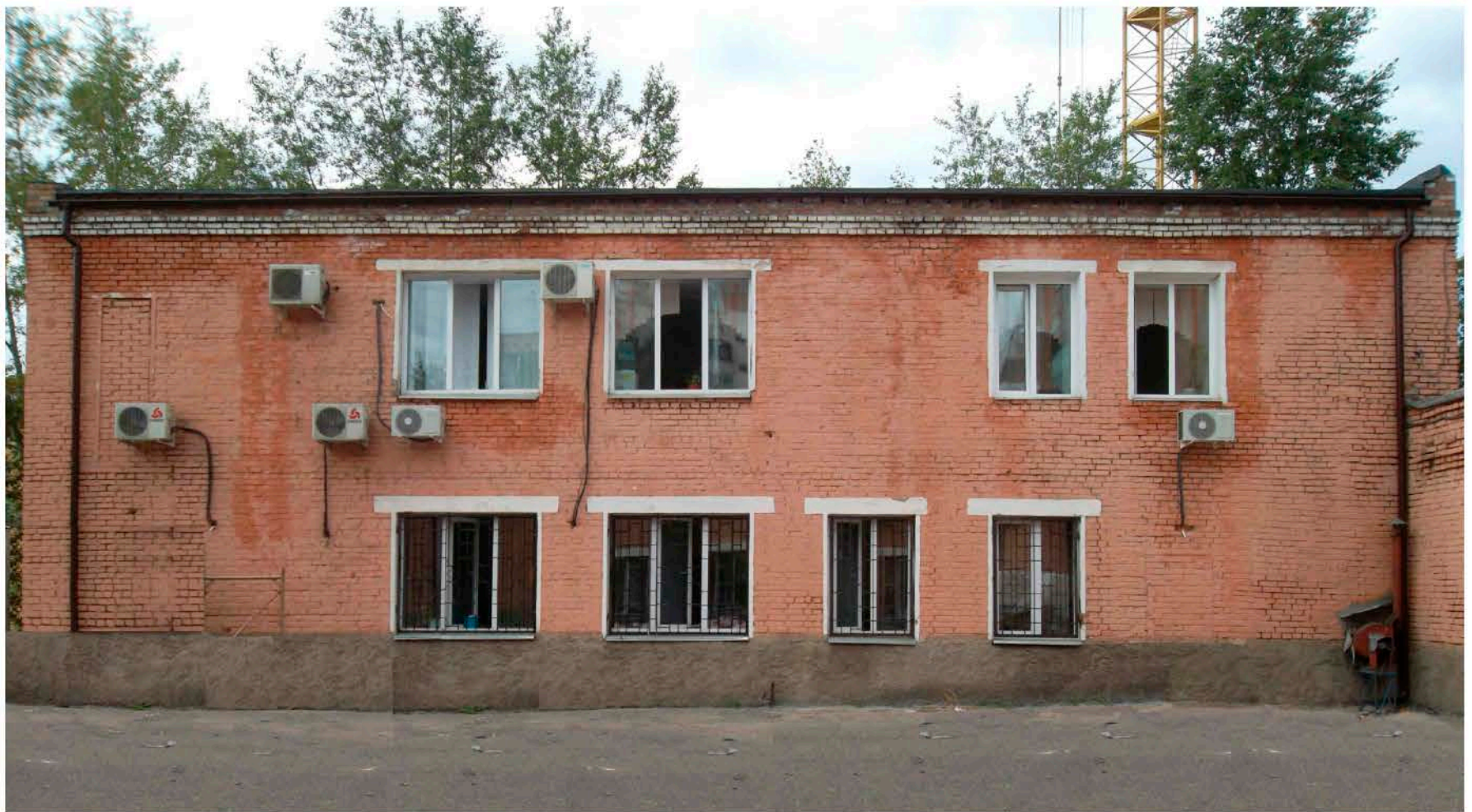
Фасад в осях А-В. Вид 7.
