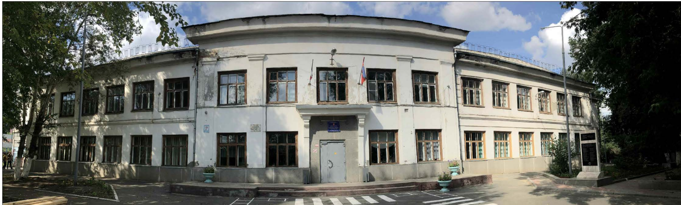
Материалы фотофиксации существующего состояния фасадов. Главный фасад в осях 1-14
