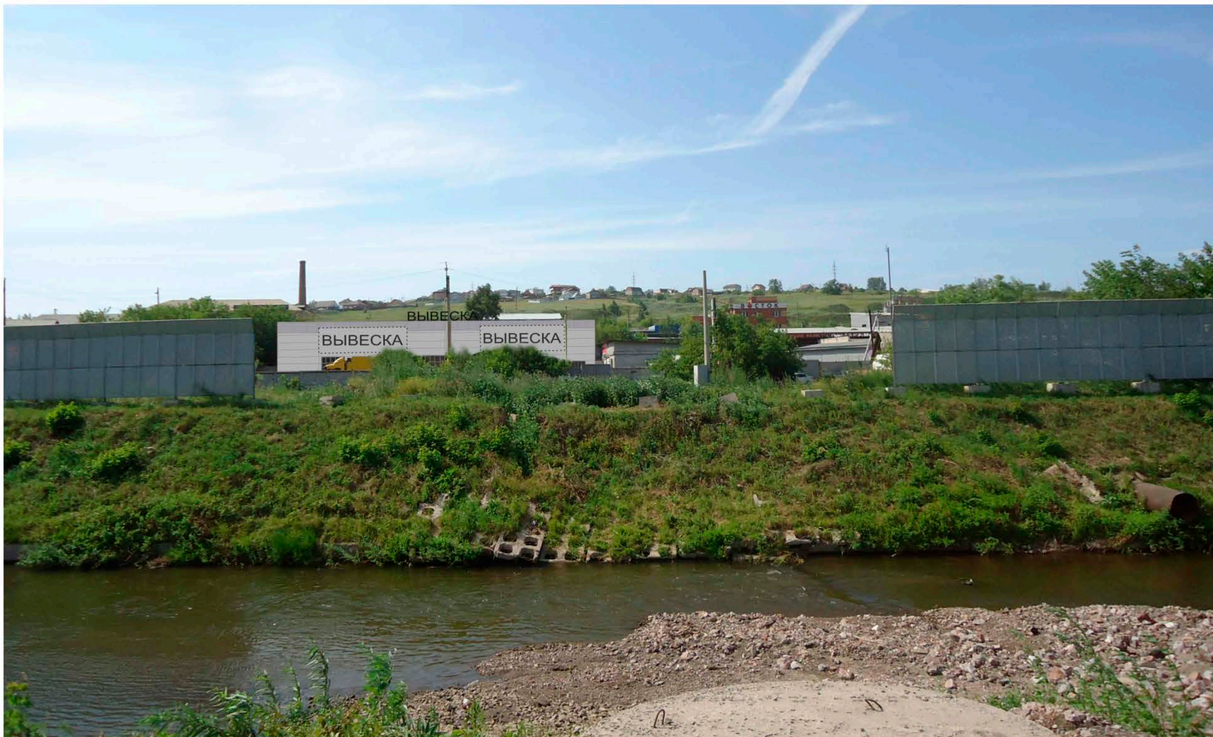
Вид главного фасада со стороны ул. Брянская
