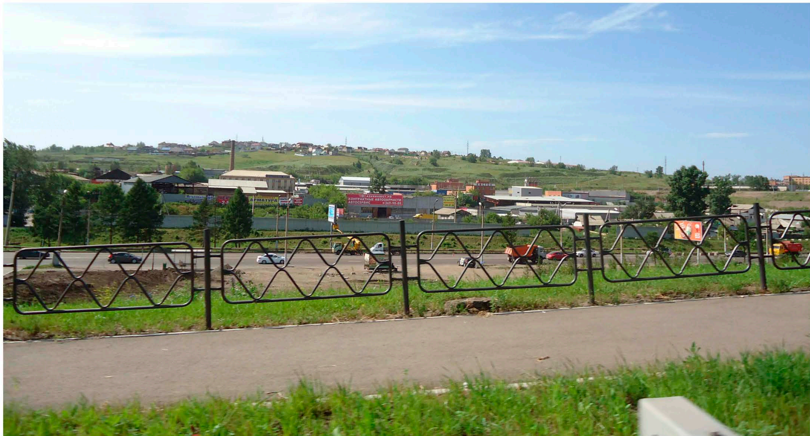
Вид главного фасада со стороны ул. 2-я Брянская
