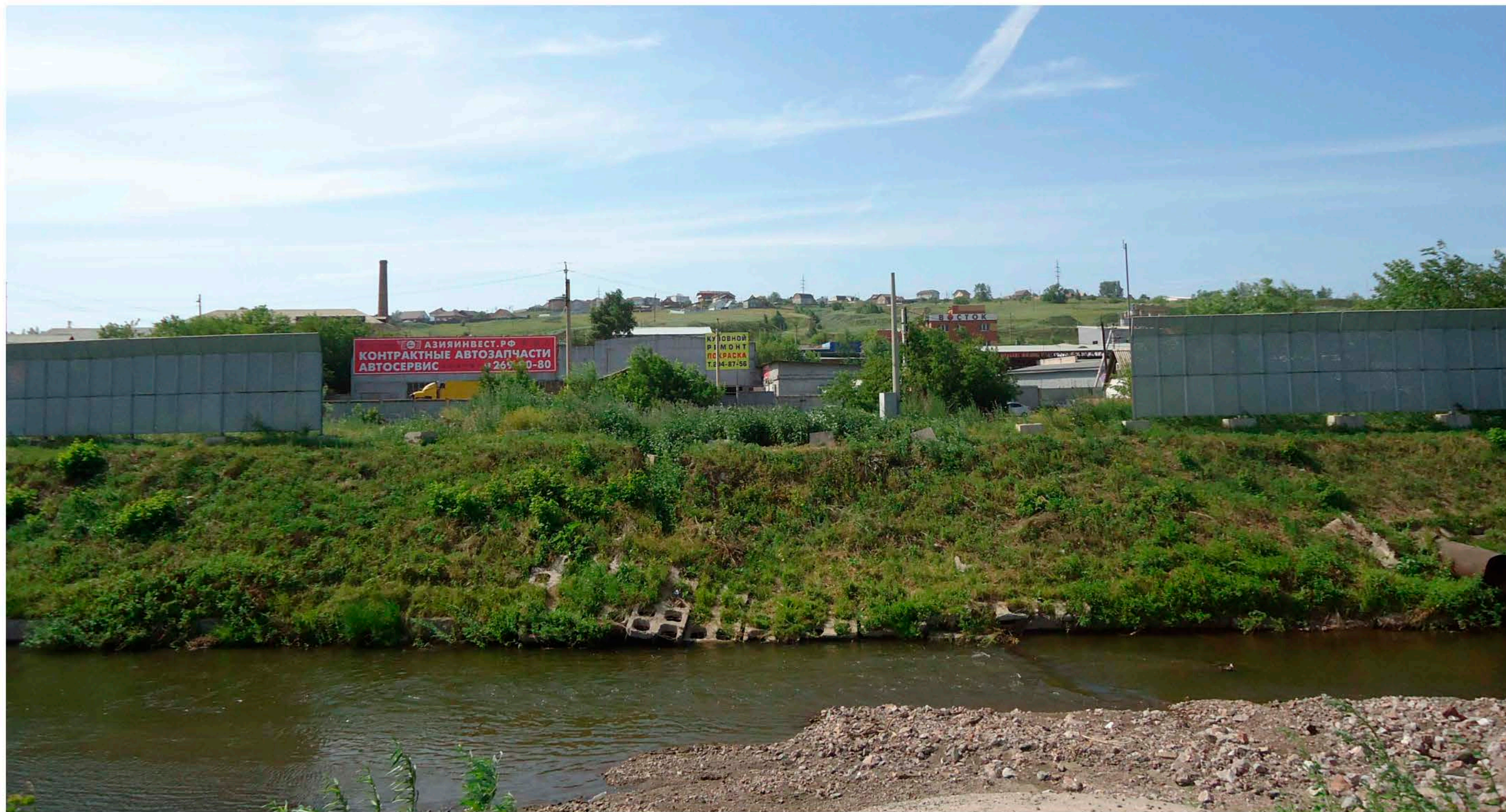
Вид главного фасада со стороны ул. Брянская
