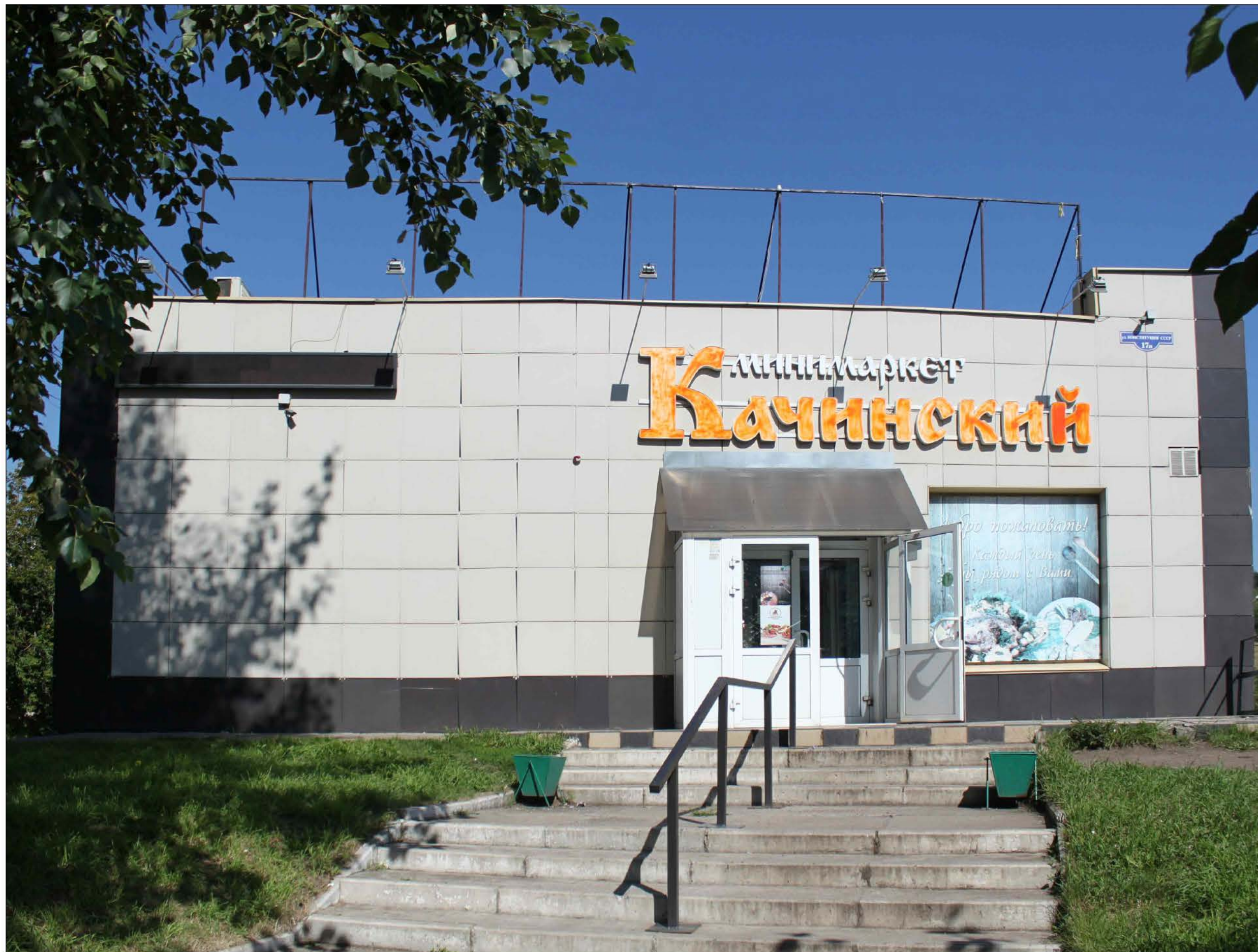
Материалы фотофиксации существующего состояния фасадов. Главный фасад в осях 1-2
