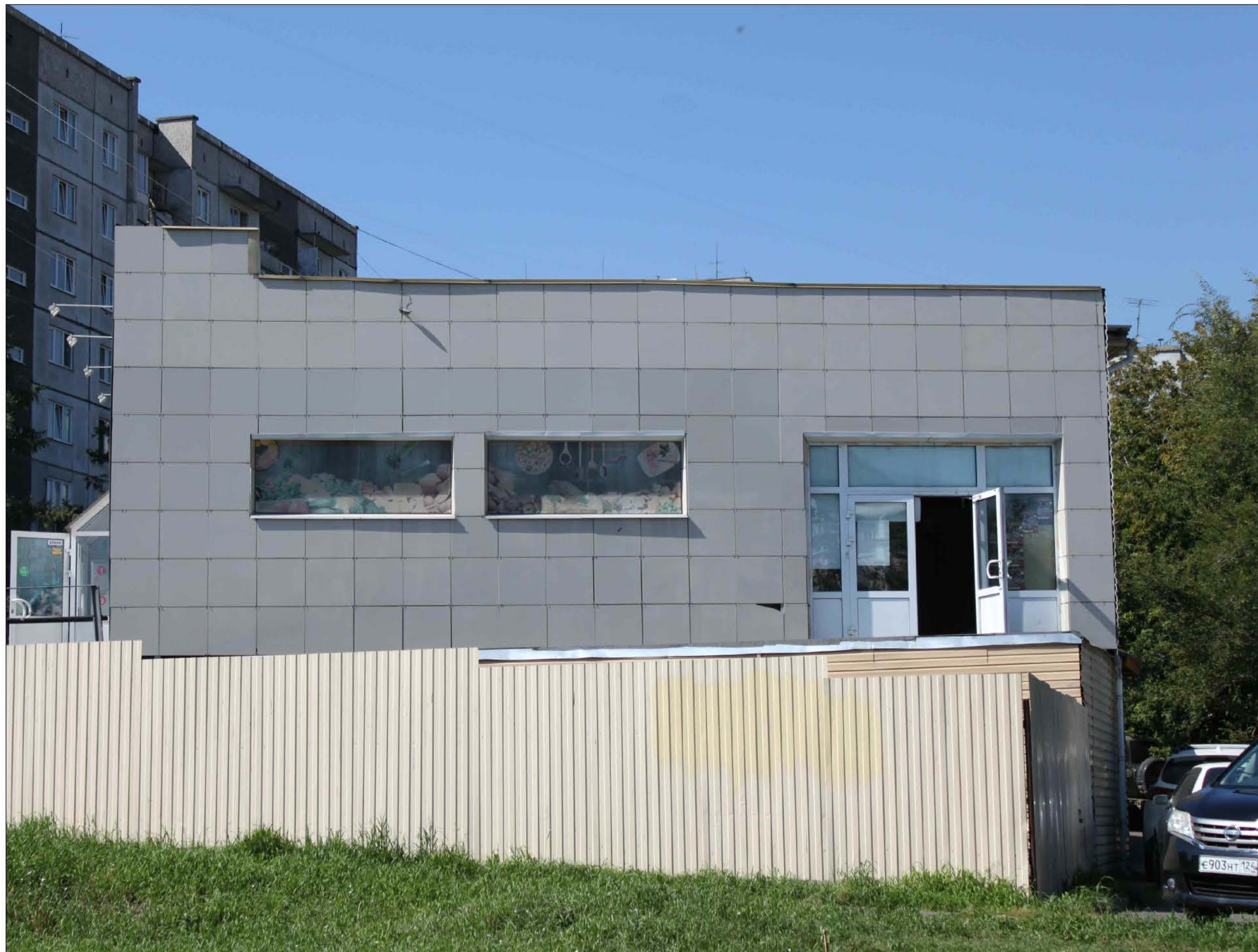
Материалы фотофиксации существующего состояния фасадов. Боковой фасад в осях А-Б
