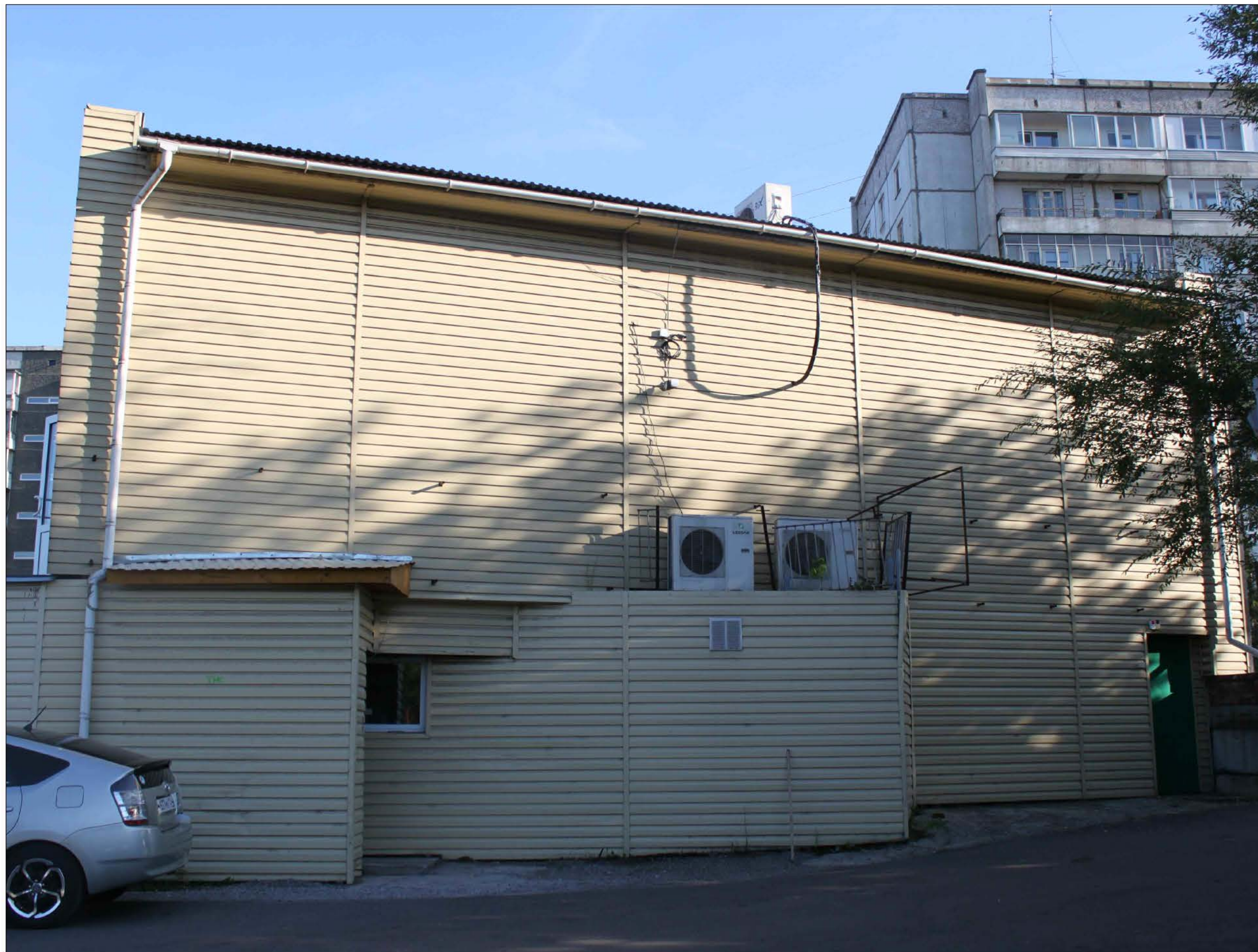
Материалы фотофиксации существующего состояния фасадов. Дворовой фасад в осях 2-1
