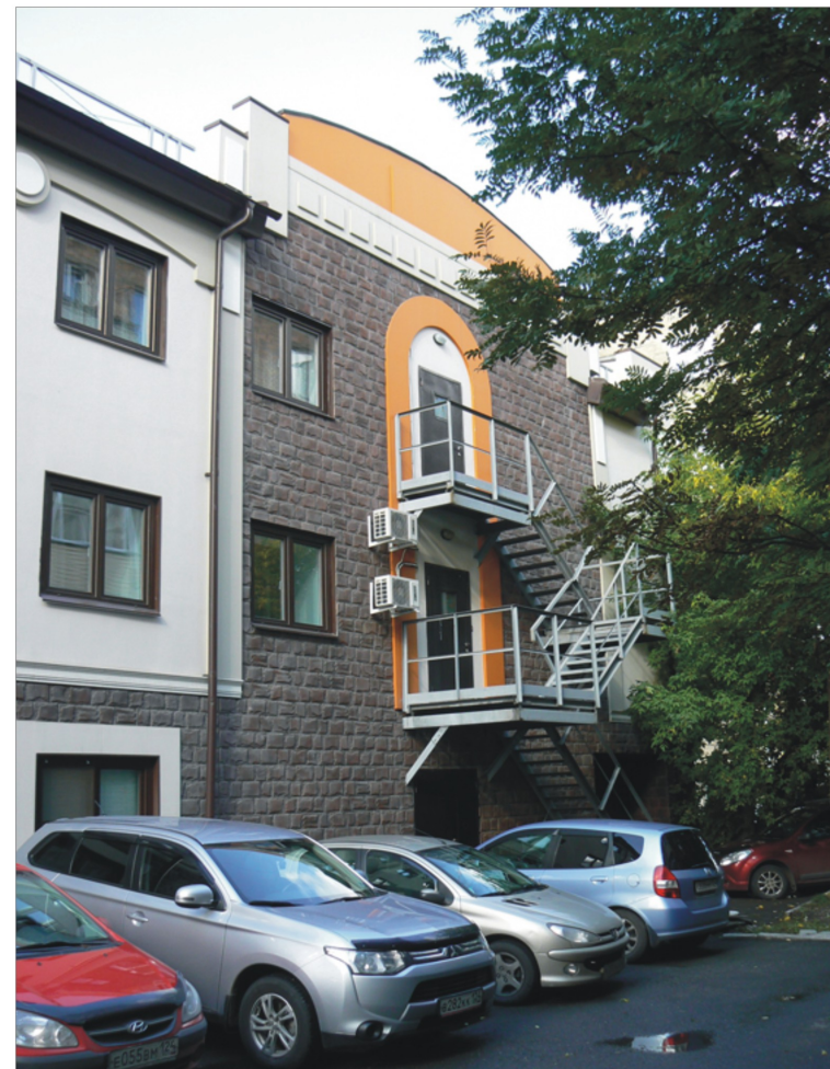
Восточный фасад. Фрагмент.
