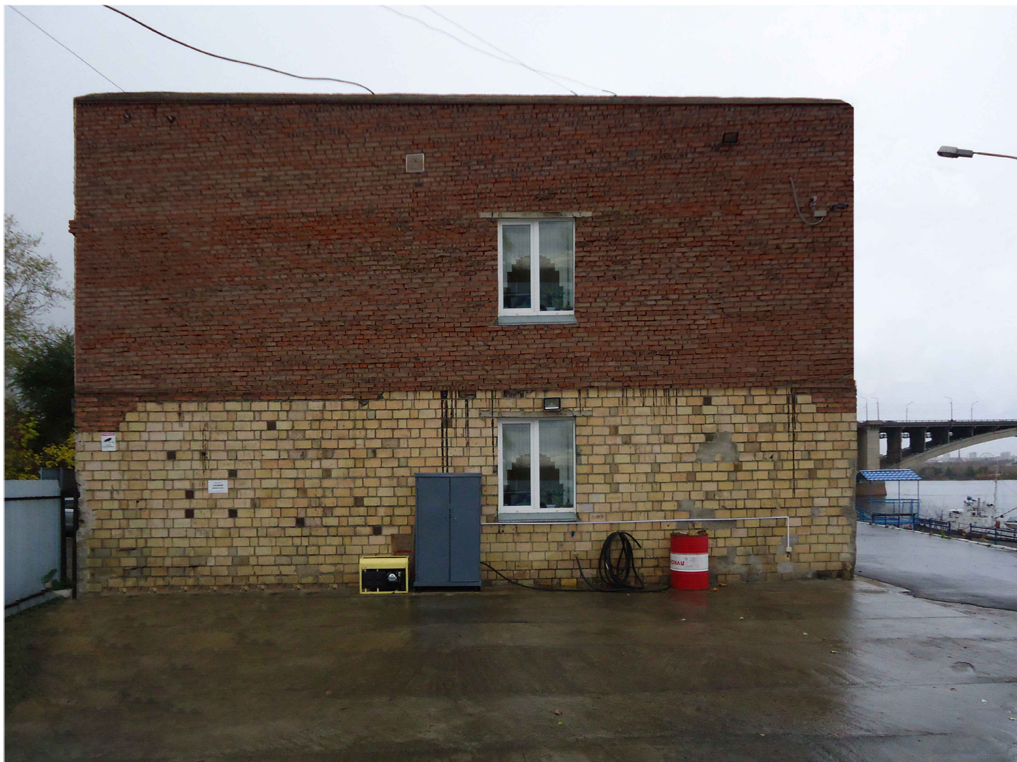
Боковой фасад со стороны ул. Остров Молокова
