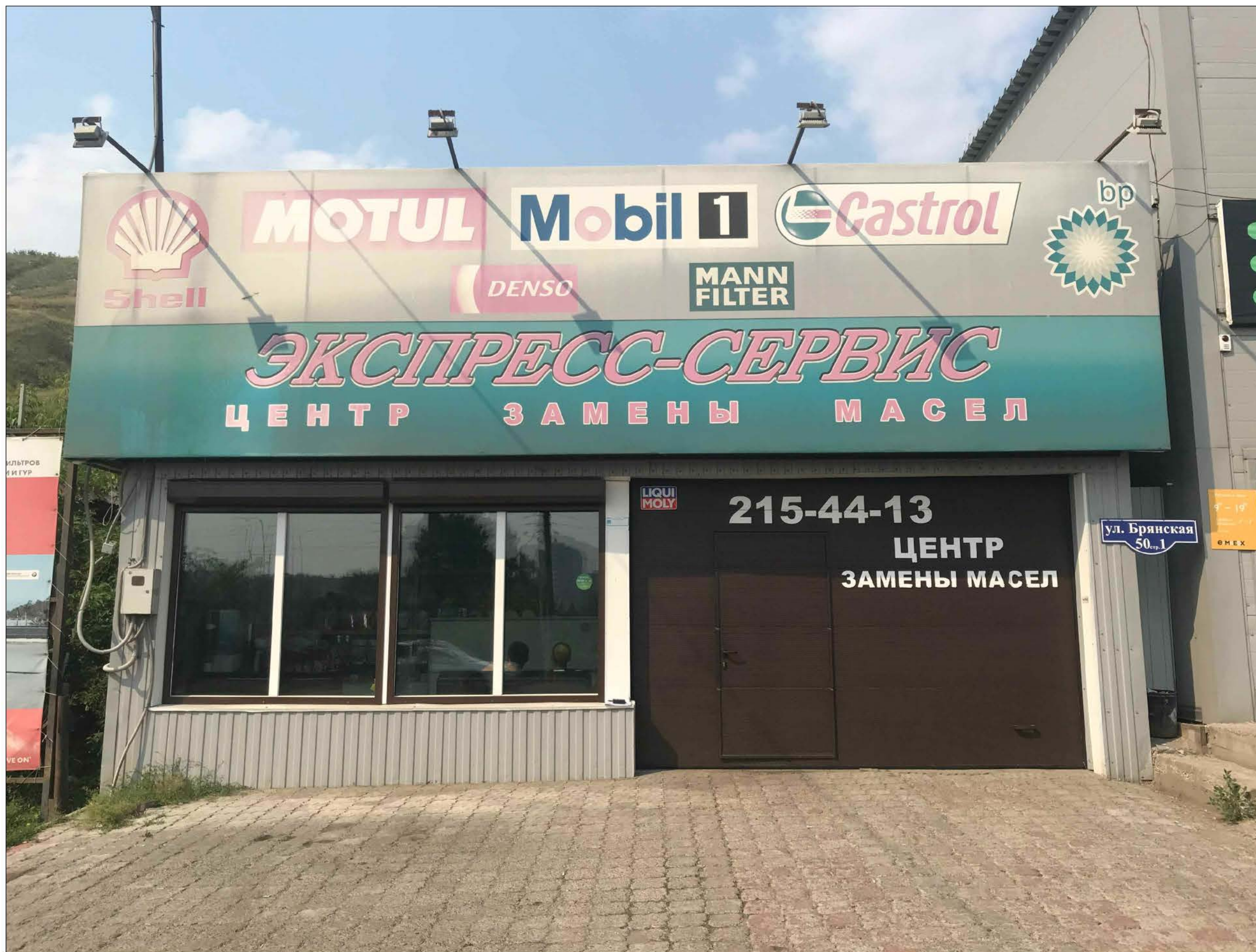
Материалы фотофиксации существующего состояния фасадов. Главный фасад
