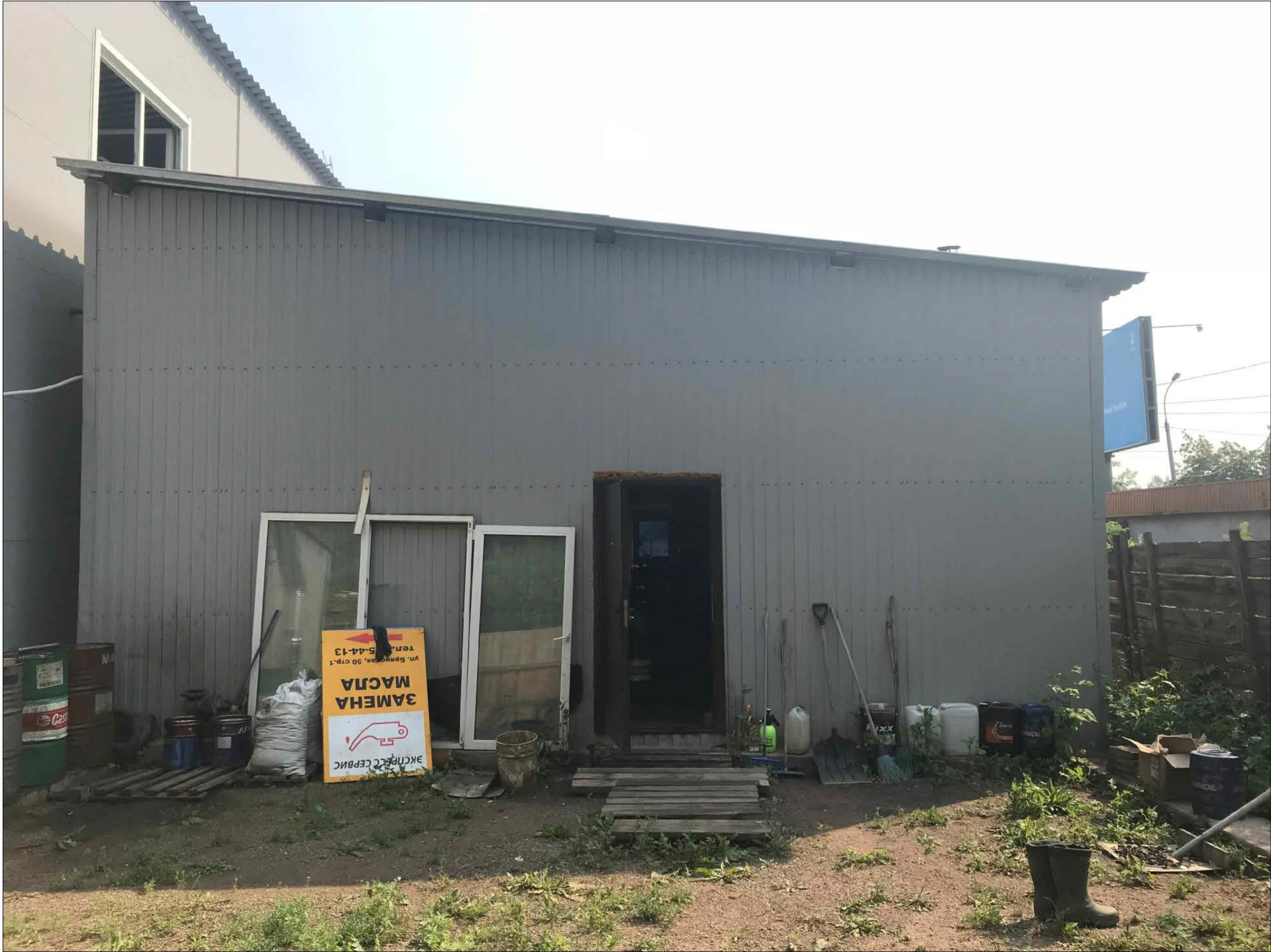
Материалы фотофиксации существующего состояния фасадов. Боковой фасад
