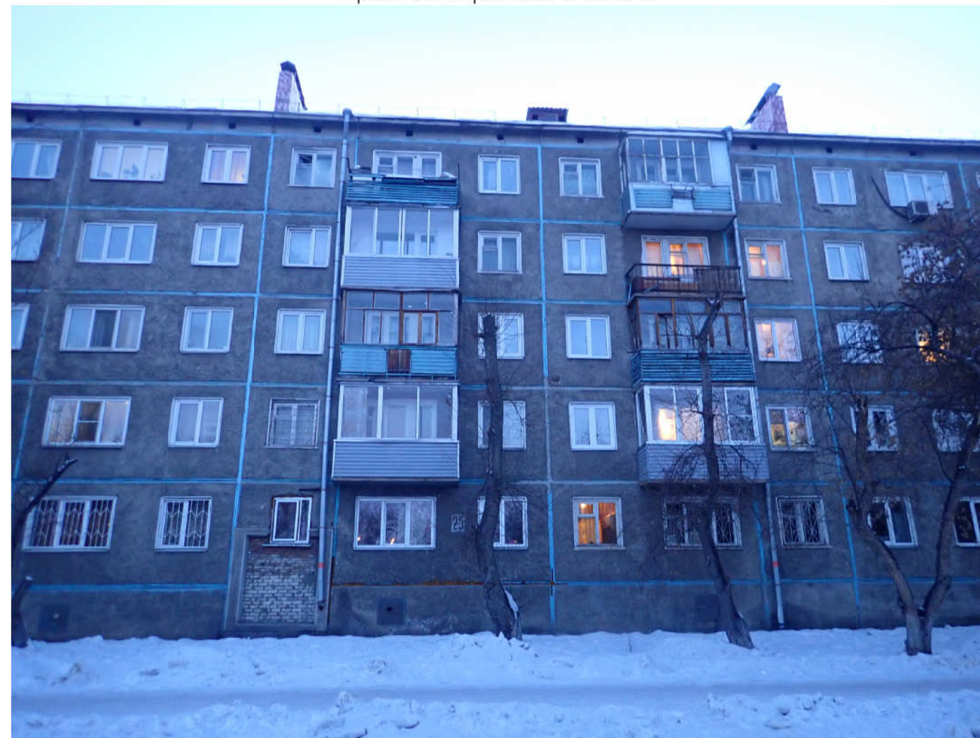
Фрагмент фасада в осях 2-1
