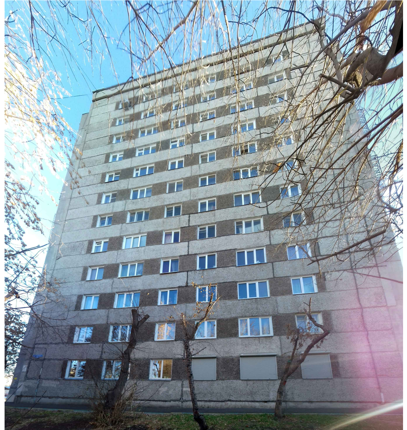
ДВОРОВЫЙ ФАСАД (СЕВЕРНЫЙ)
