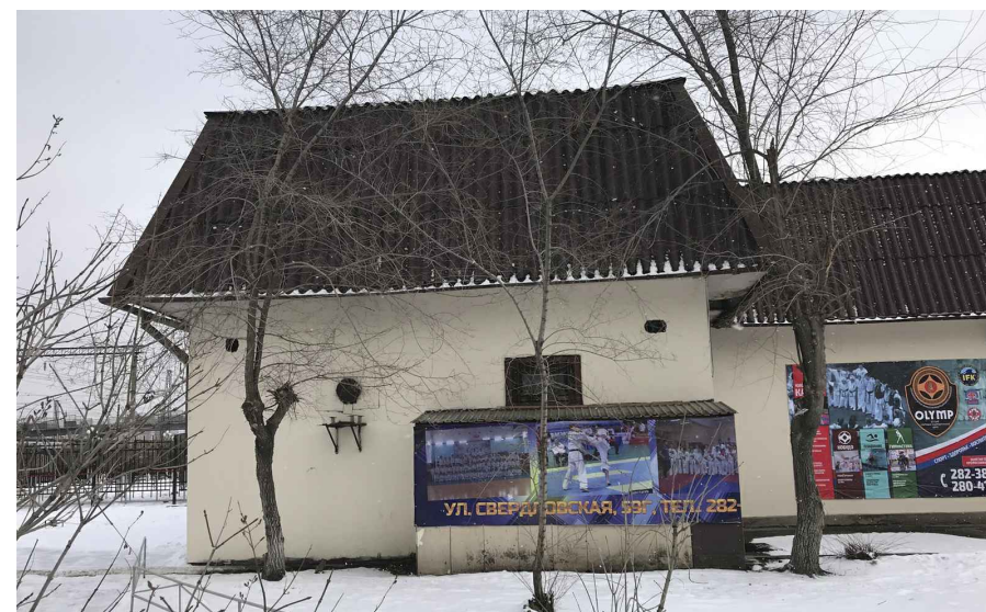
Фрагмент - 1 бокового фасада здания (западный)
