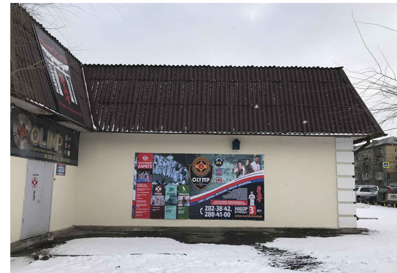
Фрагмент - 2 бокового фасада здания (западный)
