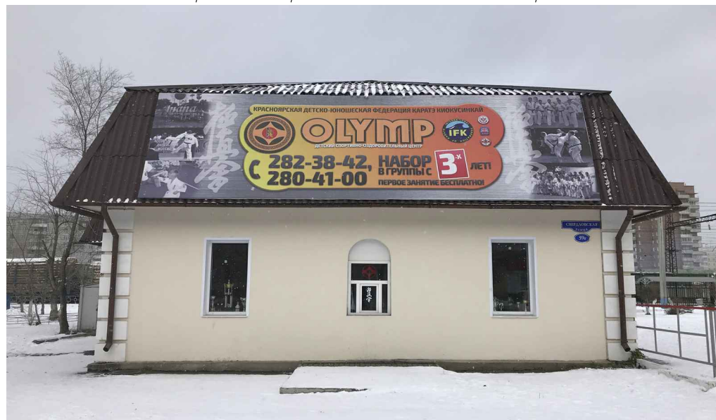
Фрагмент - 1 дворового фасада здания (северный)
