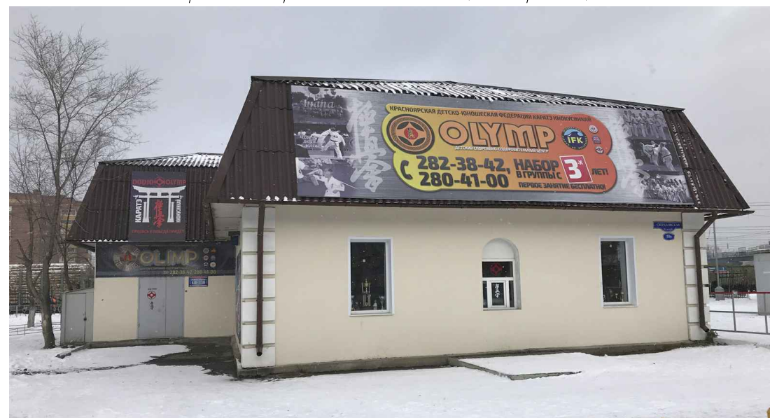
Фрагмент - 2 дворового фасада здания (северный)
