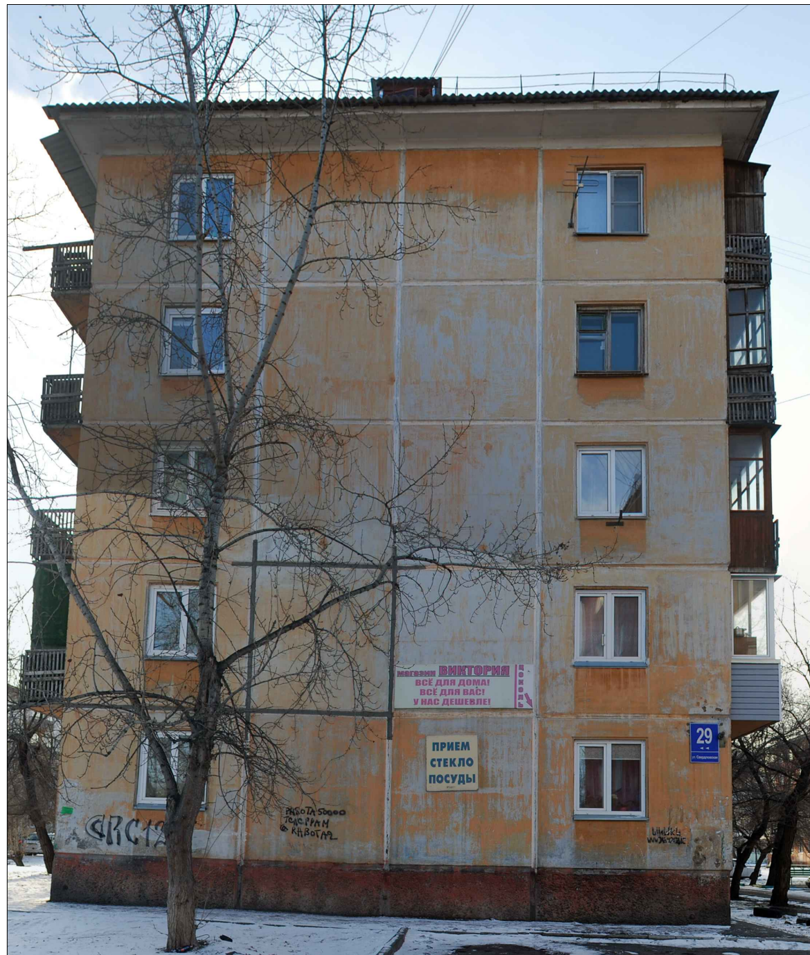
БОКОВОЙ (СЕВЕРНЫЙ) ФАСАД
