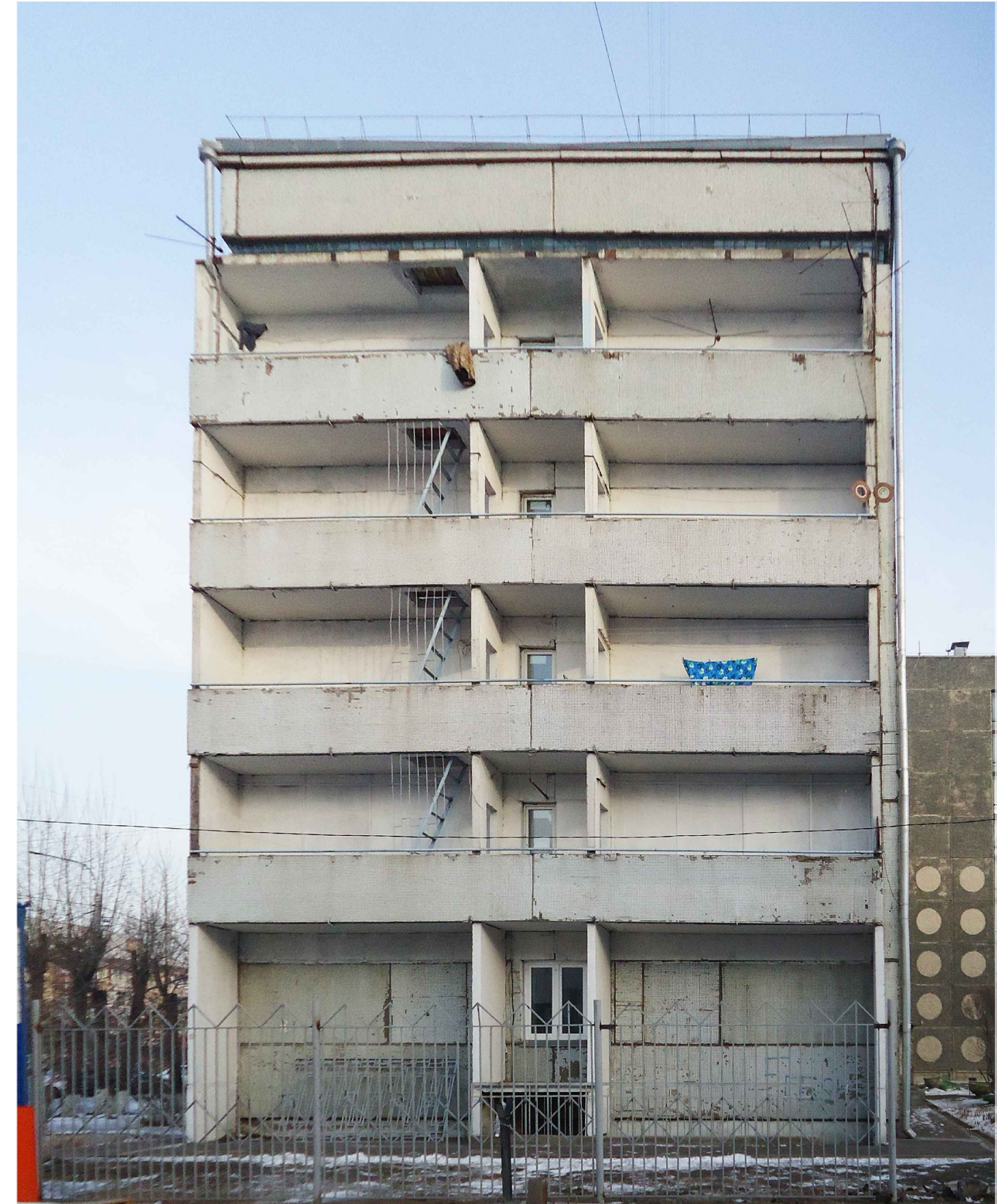
Боковой фасад со стороны Краевого центра крови
