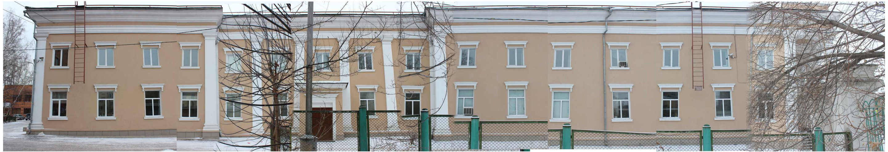
Боковой фасад (восточный фасад в осях 1-2)
