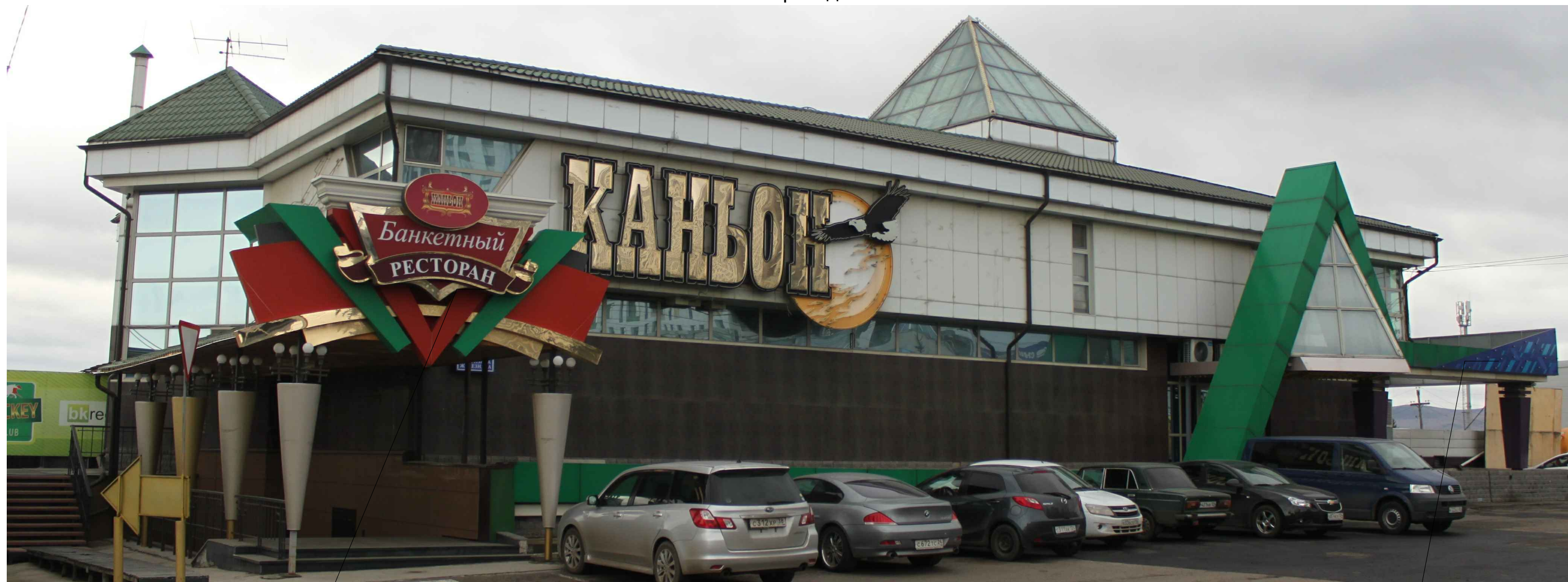
Материалы фотофиксации существующего состояния фасадов. Главный фасад 1' - 7
