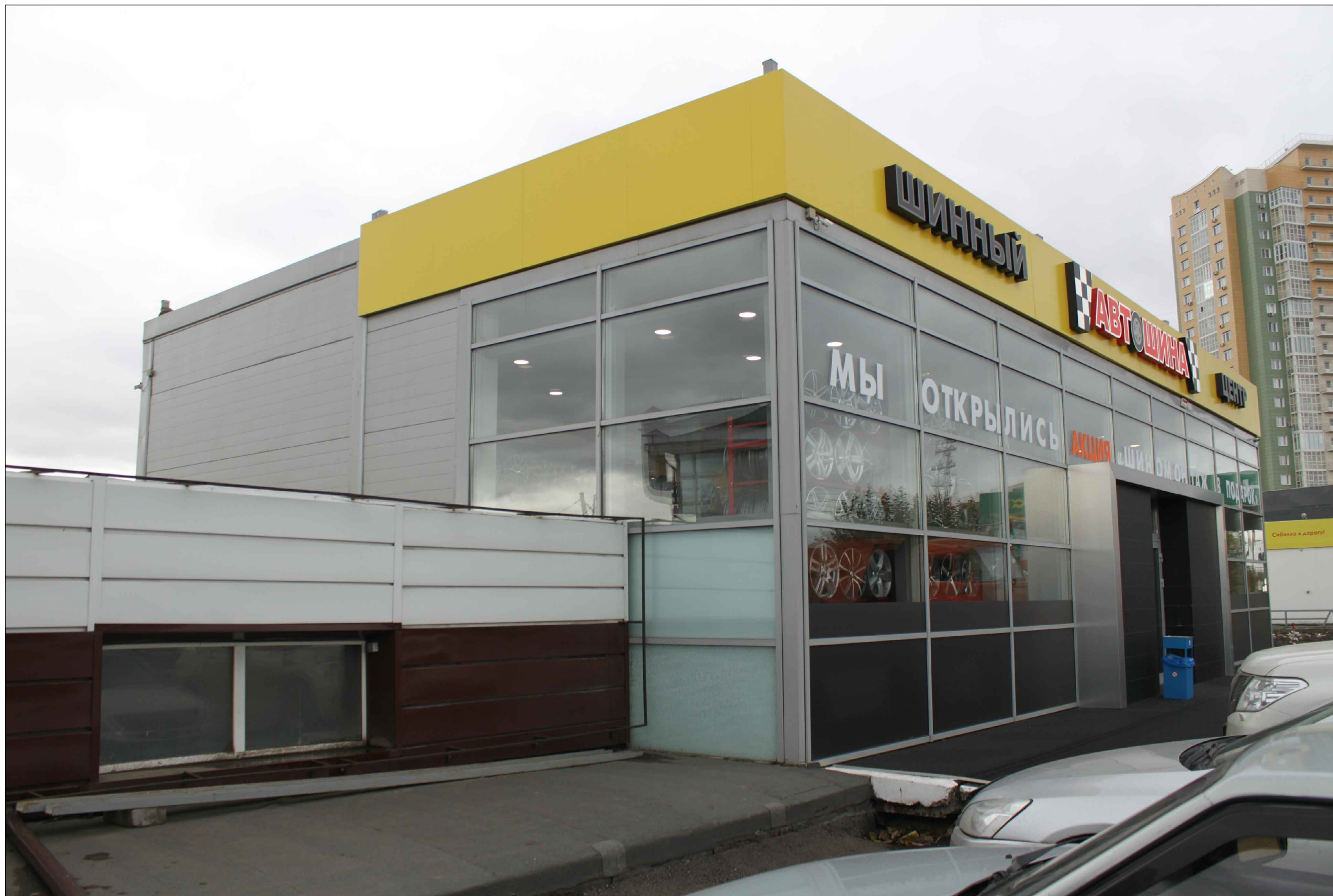
Материалы фотофиксации существующего состояния фасадов. Боковой фасад
