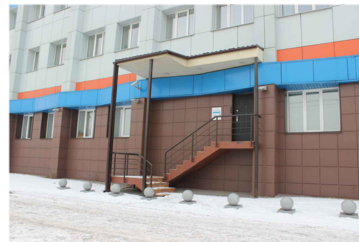
Фрагмент крыльца в осях 10-11
