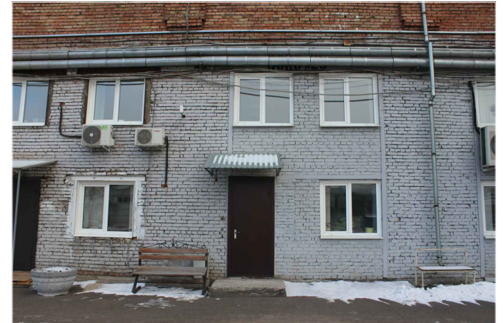
Фрагмент фасада в осях Г-Б
