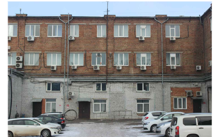
Фрагмент фасада в осях 6-4 по оси Г
