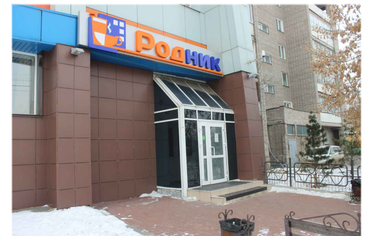
Фрагмент крыльца в осях 10-11
