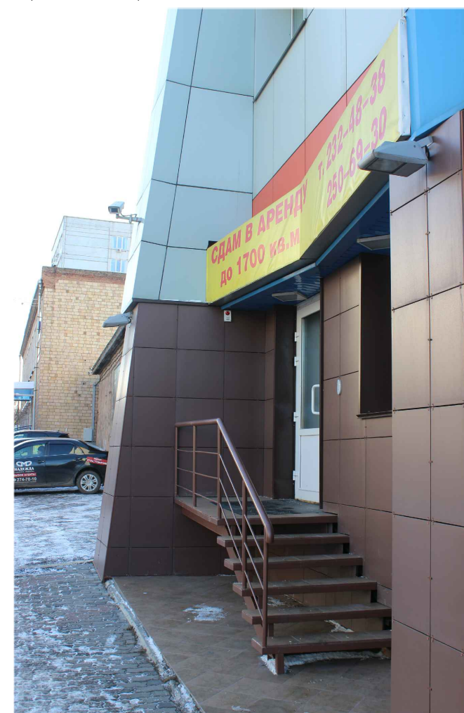
Фрагмент крыльца в осях А-Б
