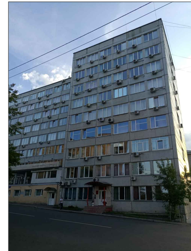
Фрагмент главного фасада
