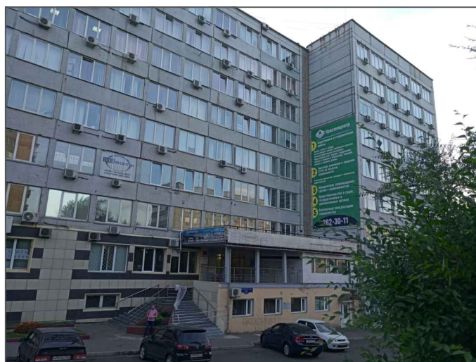
Фрагмент главного фасада
