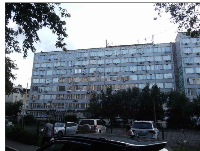
Фрагмент главного фасада
