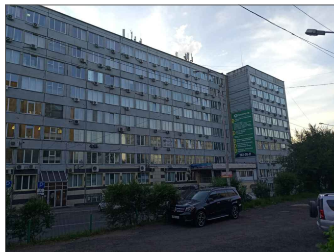
Фрагмент главного фасада
