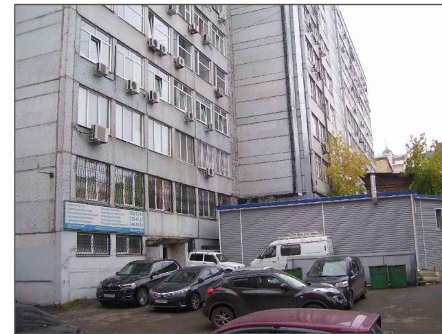
Фрагмент дворового фасада.
