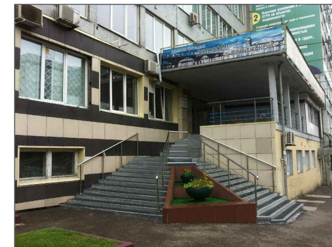
Фрагмент главного фасада
