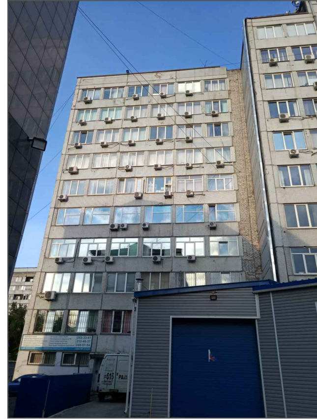
Фрагмент дворового фасада.
