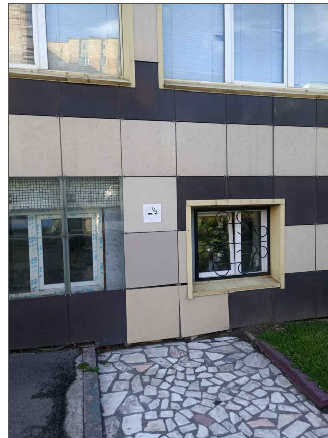
Фрагмент главного фасада
