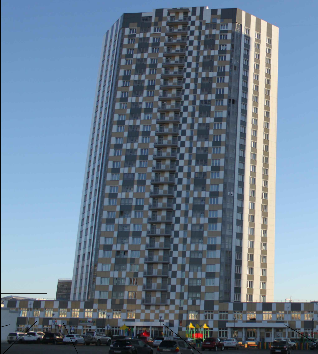
Материалы фотофиксации существующего состояния фасадов . Главный фасад в осях 1-9
