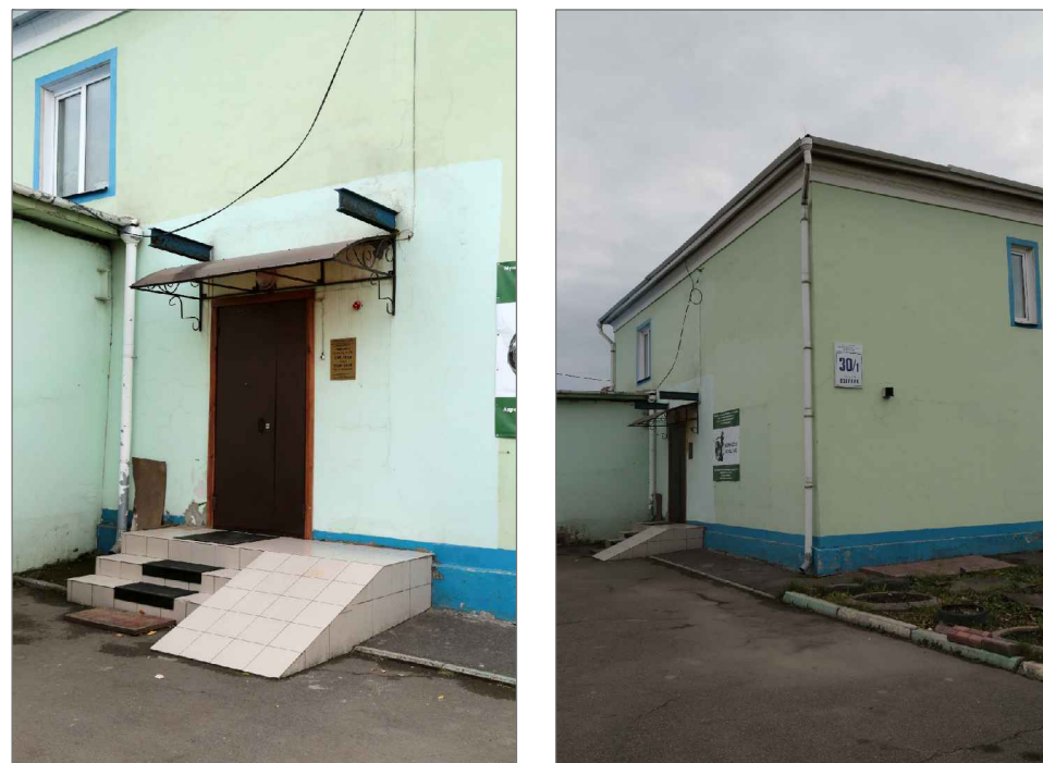
Фрагмент бокового фасада со стороны ул. Брянская
