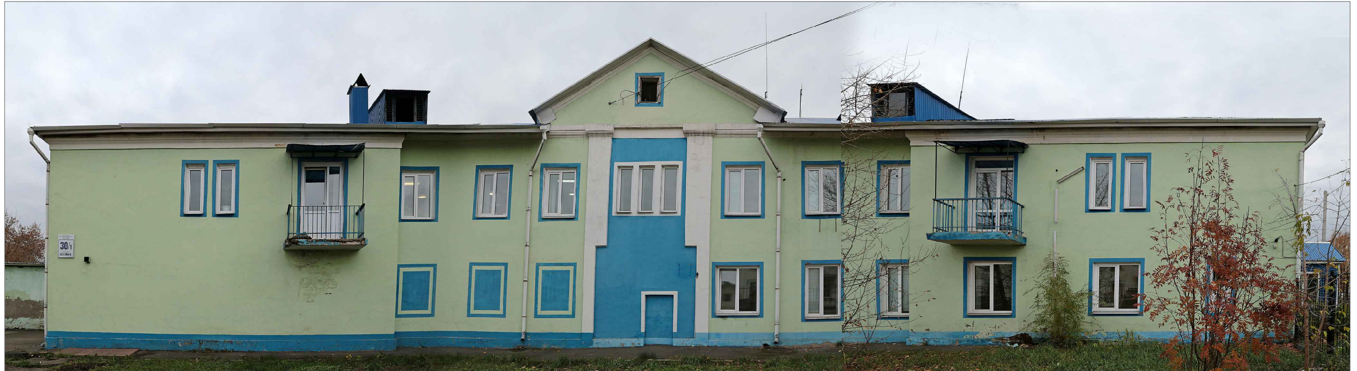
Дворовой фасад в осях 10-1
