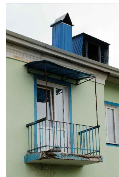
Фрагмент дворового фасада
