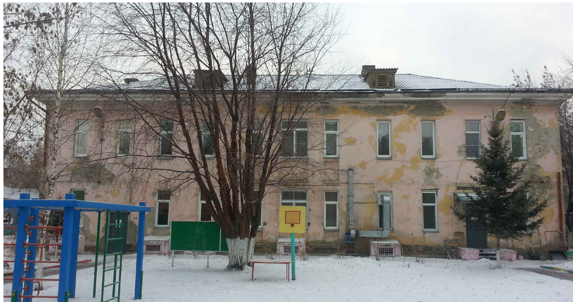
Материалы фотофиксации существующего состояния фасадов. Дворовой фасад в осях 10-1
