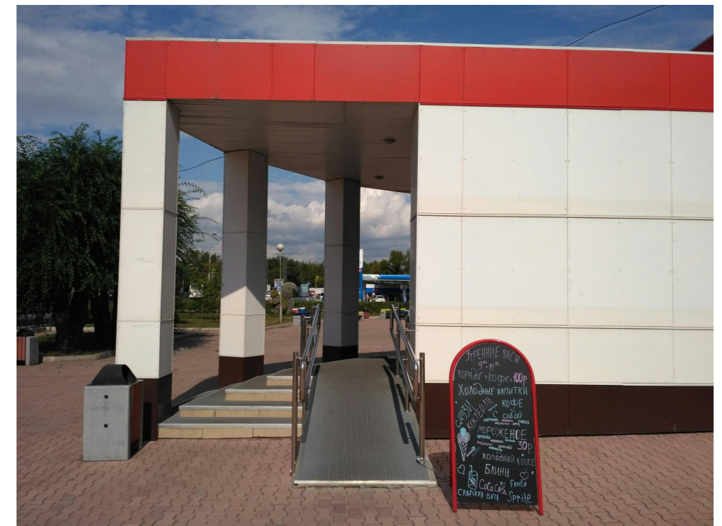
Фрагмент входной группы
