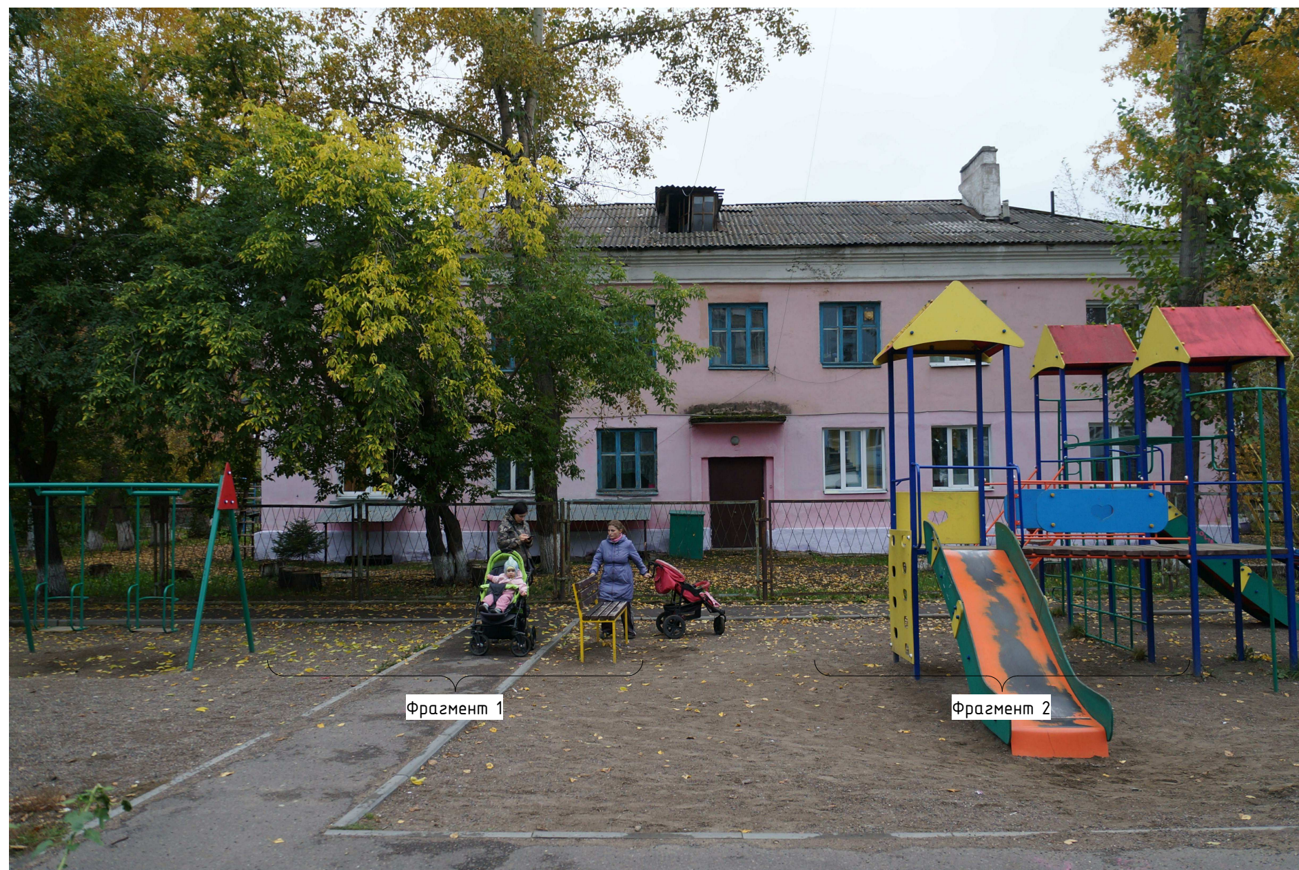
Фотофиксация заднего (северо-западного) фасада
