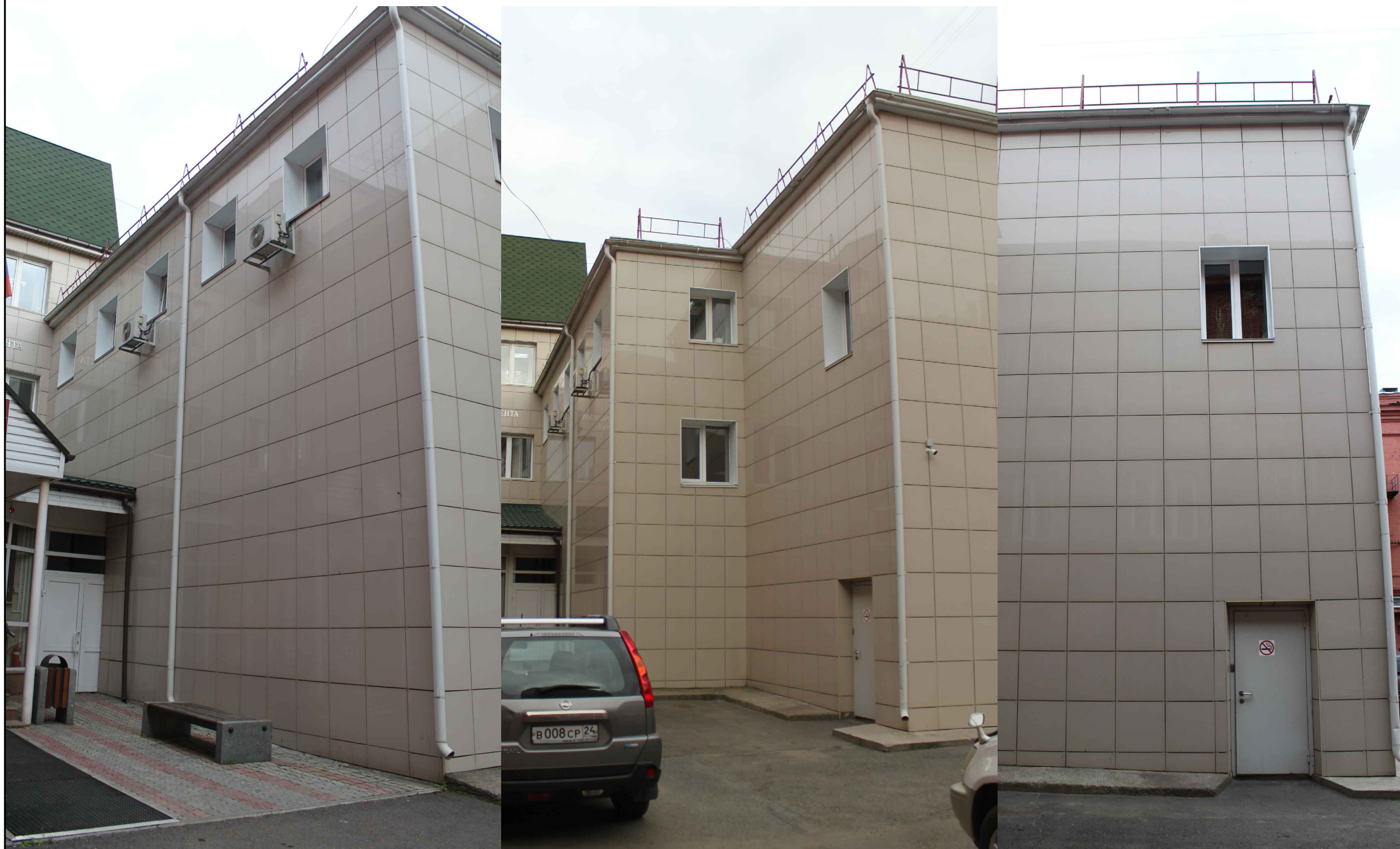
Материалы фотофиксации существующего состояния фасадов . Дворовой фасад в осях 4-1
