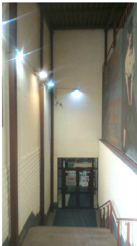
Фрагмент входа в подвал
