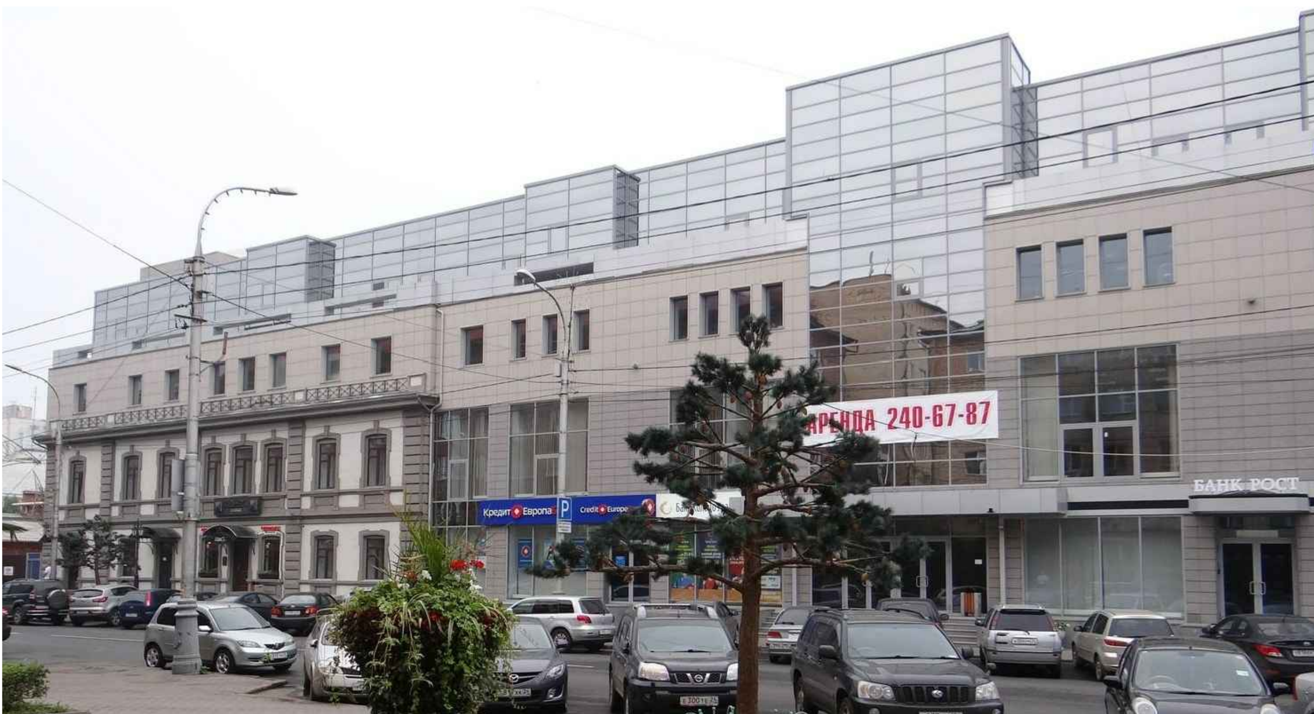
Главный фасад с улицы Мира (Северный)
