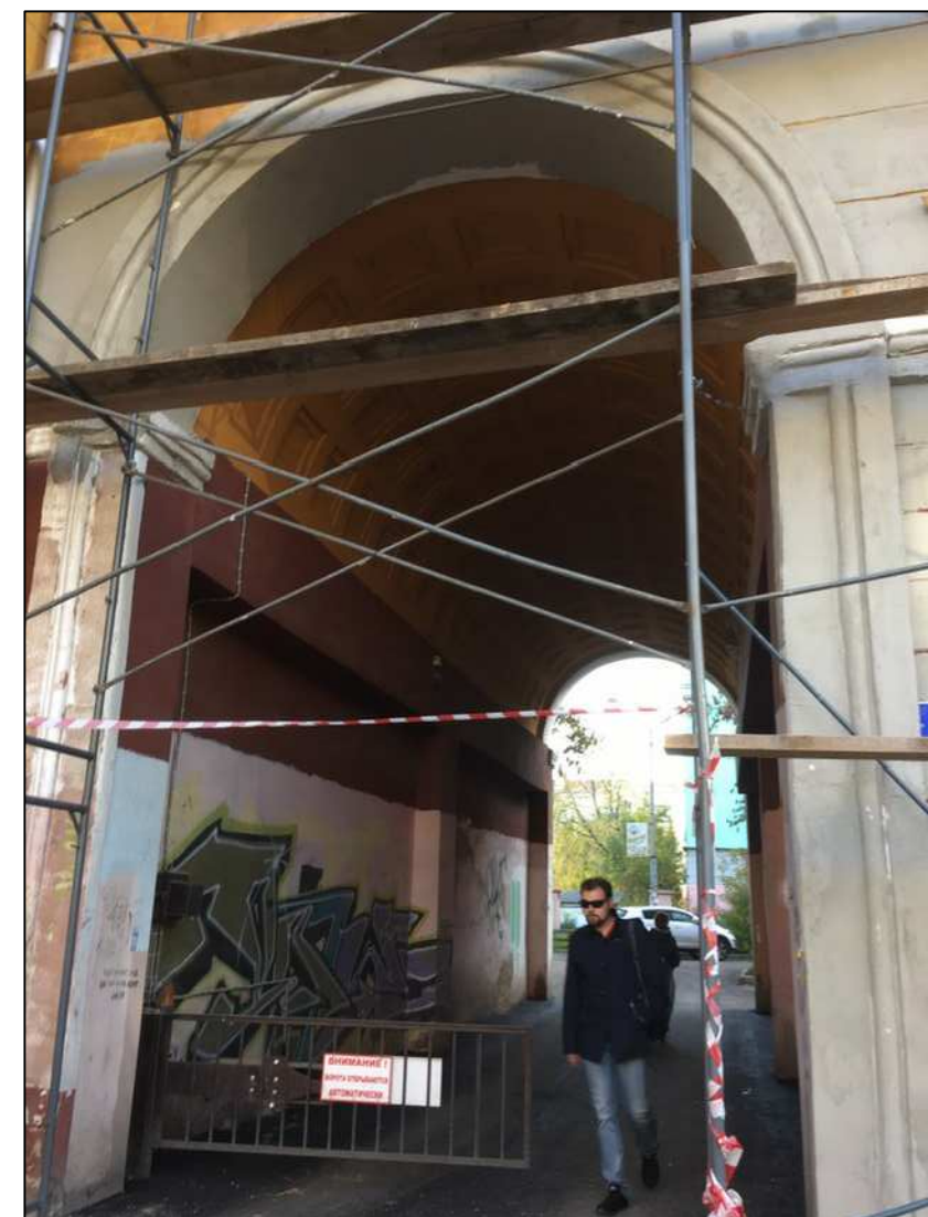
Фрагмент дворового фасада
