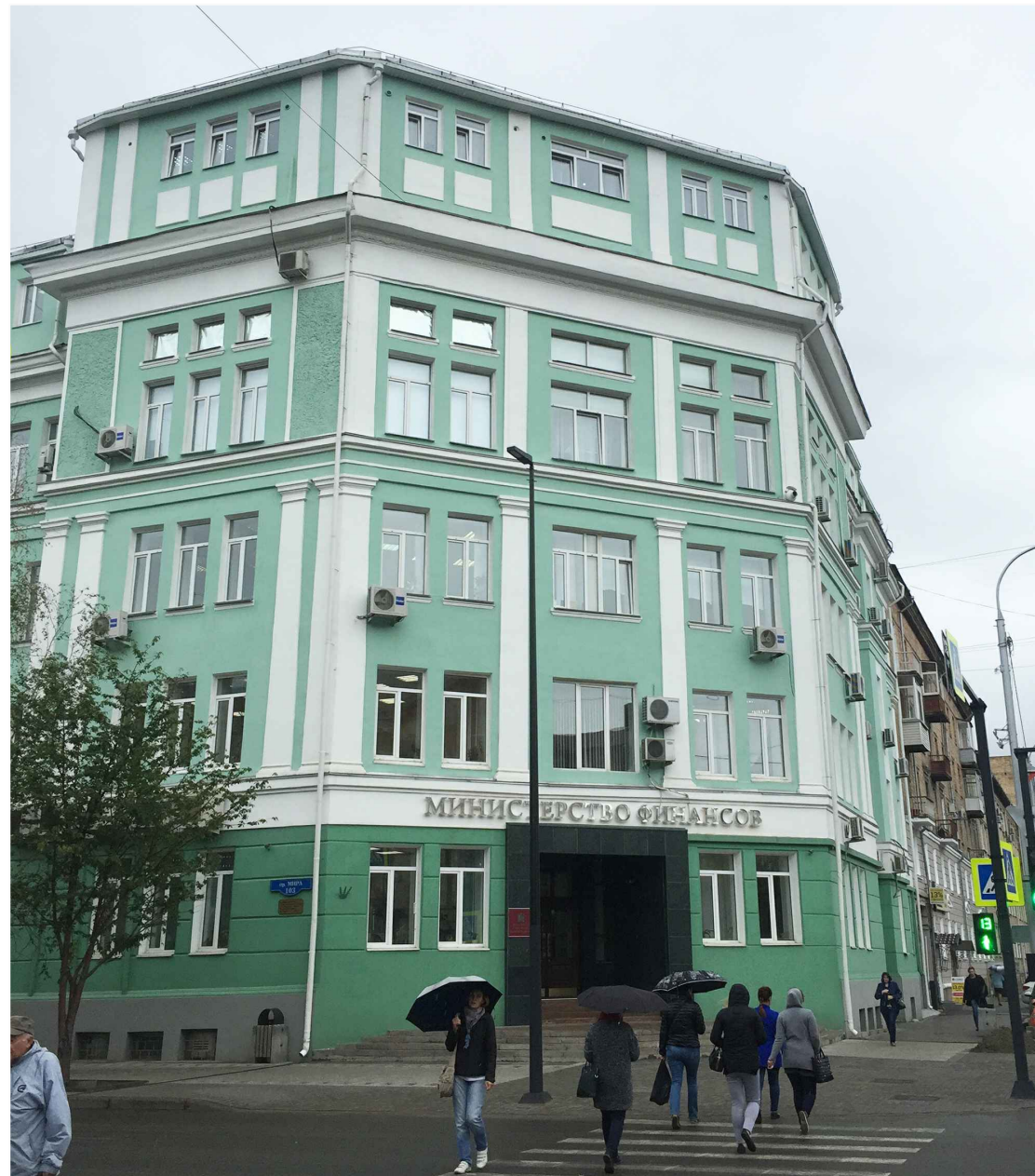
Главный фасад в осях 10-13
