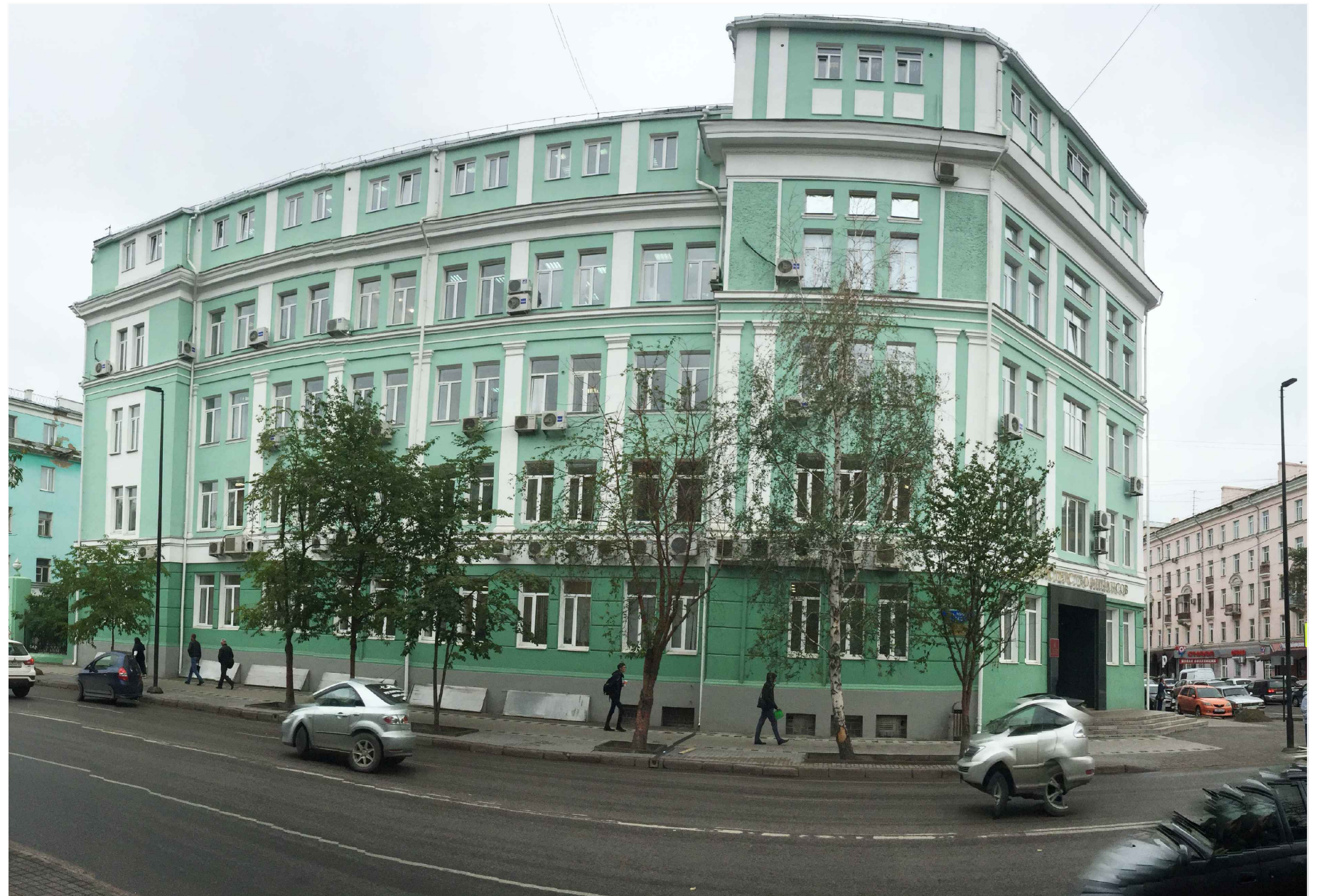
Главный фасад в осях 1-9
